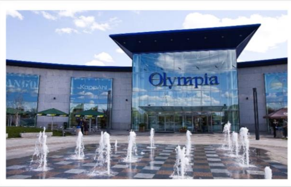
Obr. 9: Olympia Brno, nákupní zóna Brno-jih
