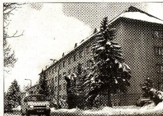
Stalingrad je nejstarší sídlíštěm ve městě. První domy se tam stavěly před padesáti lety, některé v místech s vysokou hladinou spodní vody. Dnes do řady sklepů zatéká.
