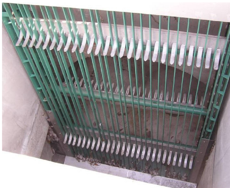
Obr. 2 Střední spodem stírané česle FONTANA R [4]
