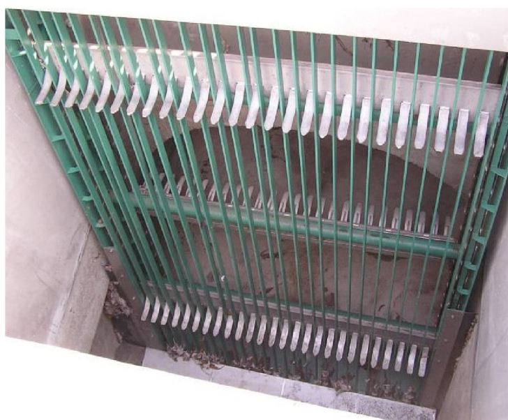
Obr. 6 Střední spodem stírané česle FONTANA R [4]
