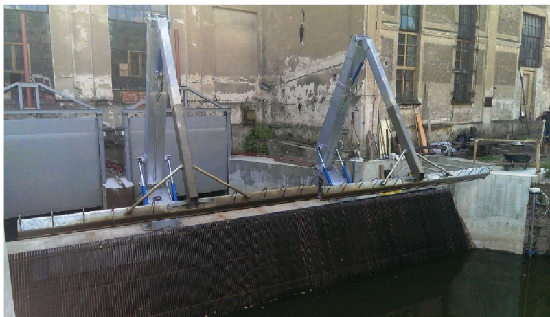
Obr. 9 Dvouramenné hydraulické česle Gyrus [6]
