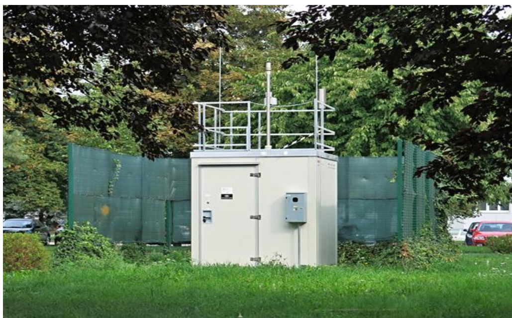
Obr. 5: Automatizovaná monitorovací stanice v Prostějově (zdroj: ČHMÚ).
