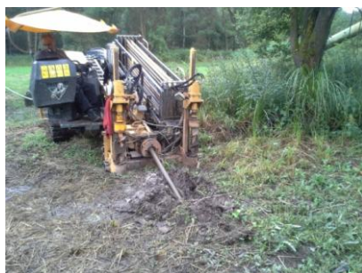
Obr. 13 a, b - stroj Vermeer Navigator D 24 x 40 – a) první pilotní vrt, b) rozšiřování druhého vrtu, vlevo zatažené nové potrubí. 28
