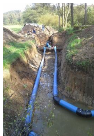
Obr. 14 a, b - a) napojení nového potrubí pomocí navrtávacích pasů, b) nové potrubí přivedené do startovací jámy. 29
