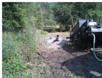
Obr. 13 a, b - stroj Vermeer Navigator D 24 x 40 – a) první pilotní vrt, b) rozšiřování druhého vrtu, vlevo zatažené nové potrubí. 28
