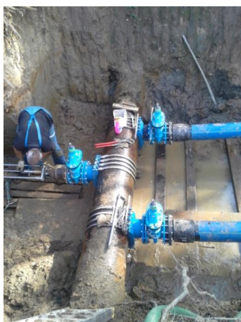
Obr. 14 a, b - a) napojení nového potrubí pomocí navrtávacích pasů, b) nové potrubí přivedené do startovací jámy. 29
