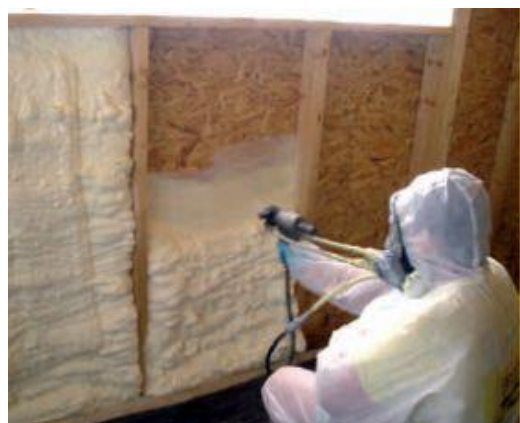
Obrázek 4: Aplikace stříkané PUR pěny [5]
