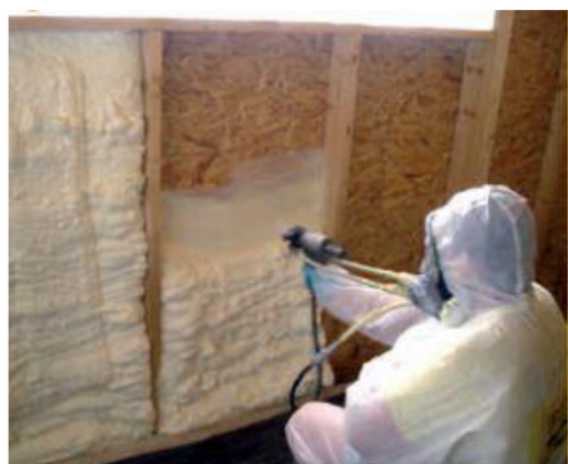
Obrázek 4: Aplikace stříkané PUR pěny [5]
