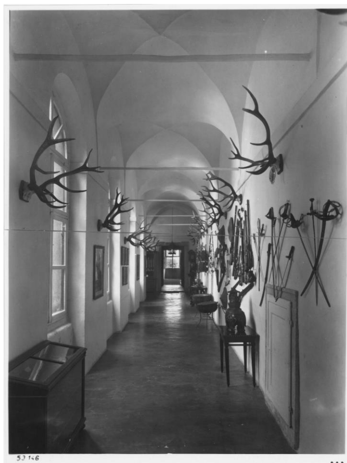
Příloha číslo 10 – Interiérová instalace ze sedmdesátých let minulého století.
