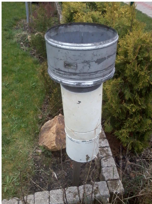
Obr. 3.2 Fotografie dočasné srážkoměrné stanice
