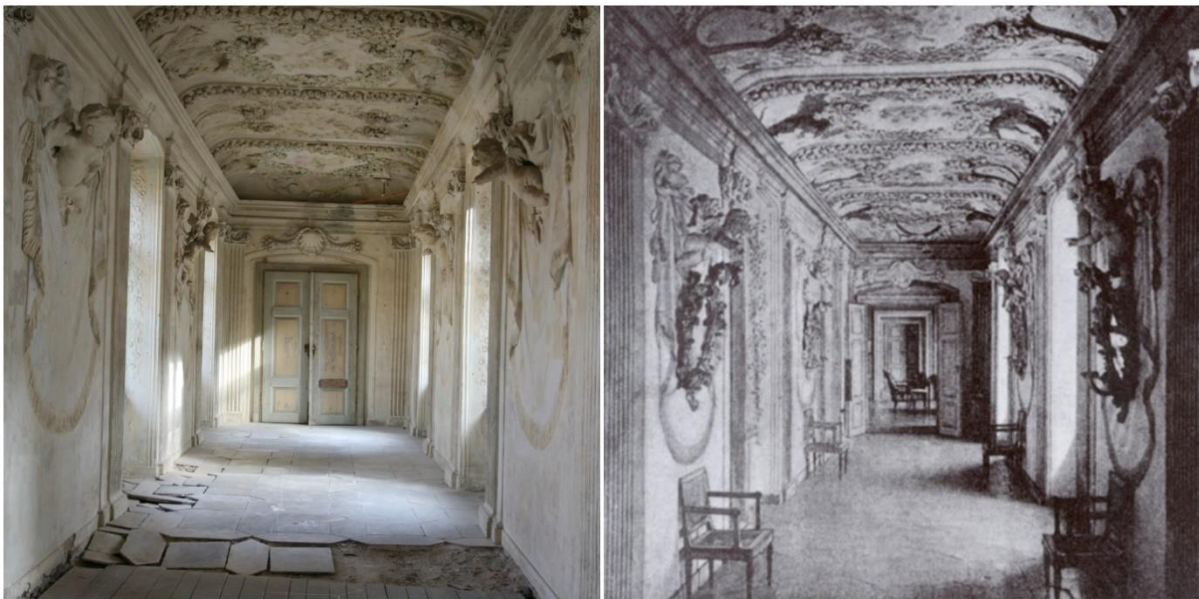
obr. 27 tzv. Andělská chodba zámku v Uherčicích dnešní stav v porovnání se stavem před poničením výzdob (kolem r. 1900). Baldassarre Fontana, štuková výzdoba interiérů zámku Uherčice, před 1696, štuk, zámek Uherčice.
