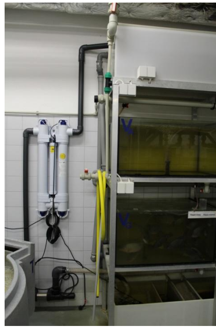
Obr. 3: Topné těleso a UV zařízení
