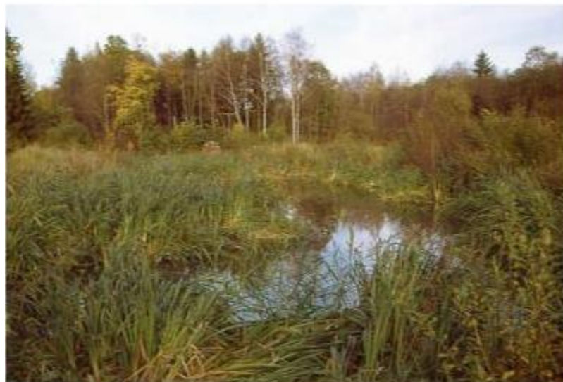
Obrázek 22: Umělý mokřad s volnou hladinou (foto J. Vymazal).
