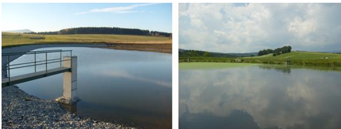
Obrázek 13: Biologické dočišťovací nádrže ( https://www.asio.cz ).
