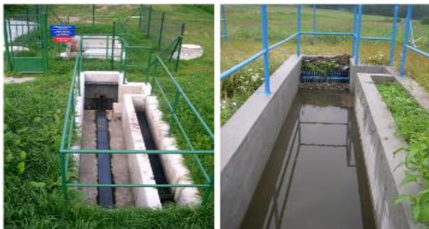
Obrázek 9: Česle a horizontální lapák písku a štěrku na KČOV Petrovice u Havlíčkova Brodu (vlevo) a ve Skleném u Žďáru nad Sázavou (vpravo). Na levé straně je ukázka dobře provozovaného lapáku, vpravo ukázka lapáku bez řádné údržby, foto Jan Vymazal ( https://docplayer.cz/19042760-Korenove-cistirny-odpadnich-vod.html ).
