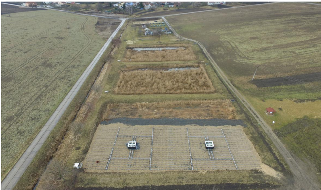
Obrázek30: Ukázka vertikálních (vepředu) a horizontálních (vzadu) filtrů (archív ÚVHK).
