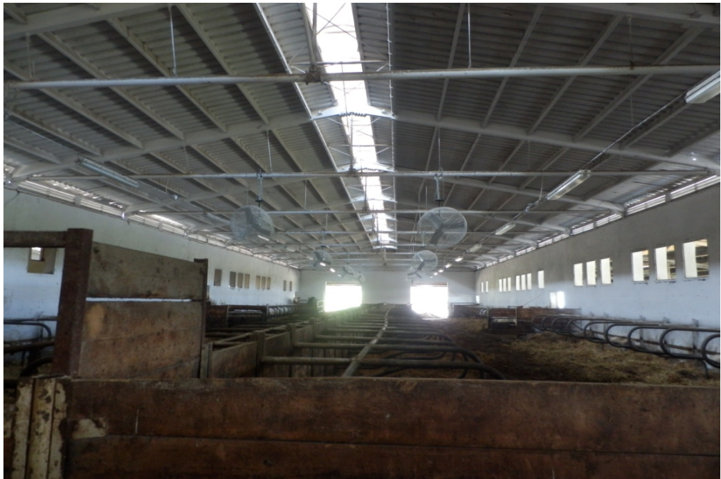
Foto č. 9: Konstrukce střechy se střešní hřebenovou štěrbinou a nově instalovanými větráky v dolní stáji („Foto: Sandra Studená“)
