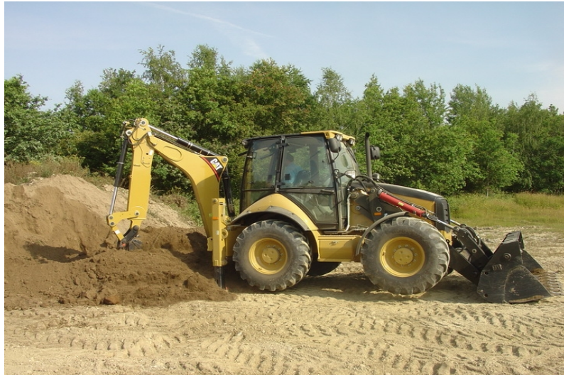
Obr. Rypadlo-nakladač Caterpillar 434E2
