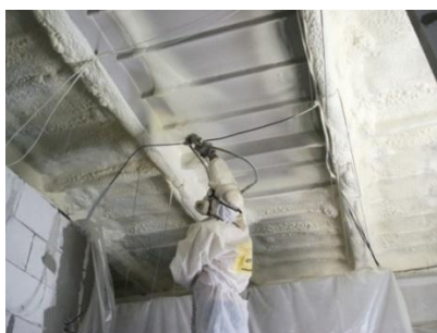
Obrázek 5: Stříkaná izolace – PUR pěna
