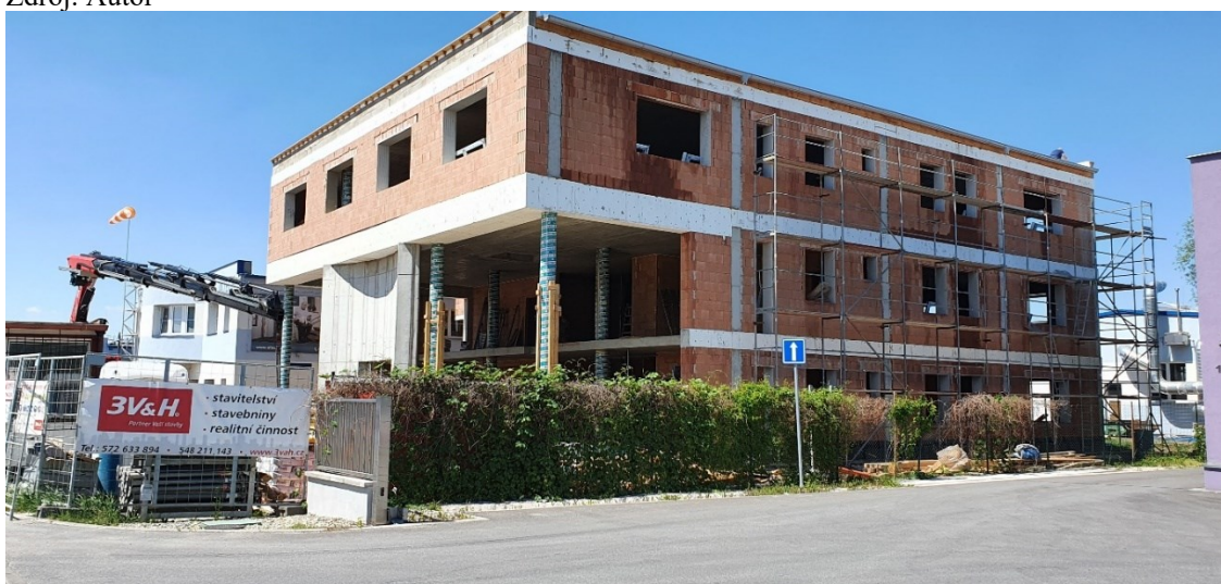
Fotografie ze dne 20.5.2020 - práce výstavby výzkumného a vývojového centra společnosti Altech Zdroj: Autor
