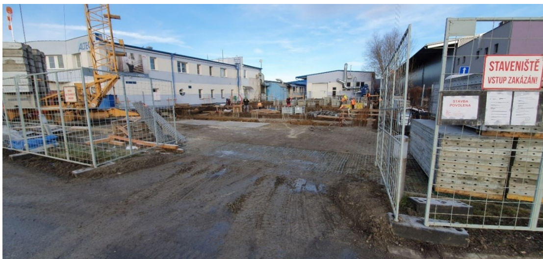
Fotografie ze dne 29.1.2020 - práce výstavby výzkumného a vývojového centra společnosti Altech Zdroj: Autor
