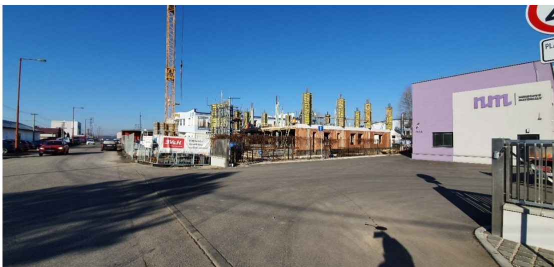
Fotografie ze dne 5.3.2020 - práce výstavby výzkumného a vývojového centra společnosti Altech Zdroj: Autor
