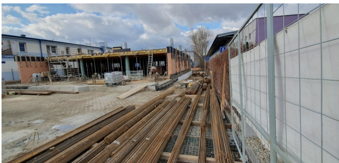
Fotografie ze dne 21.2.2020 - práce výstavby výzkumného a vývojového centra společnosti Altech Zdroj: Autor
