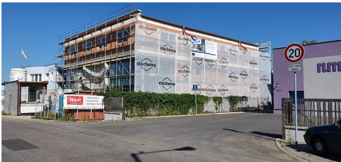
Fotografie ze dne 10.7.2020 - práce výstavby výzkumného a vývojového centra společnosti Altech Zdroj: Autor
