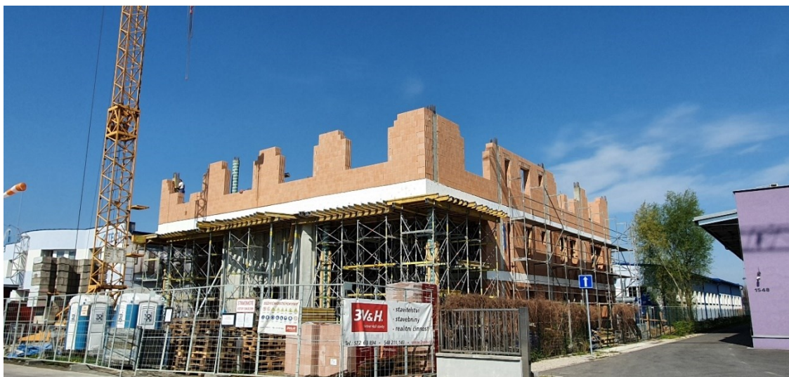
Fotografie ze dne 17.4.2020 - práce výstavby výzkumného a vývojového centra společnosti Altech Zdroj: Autor
