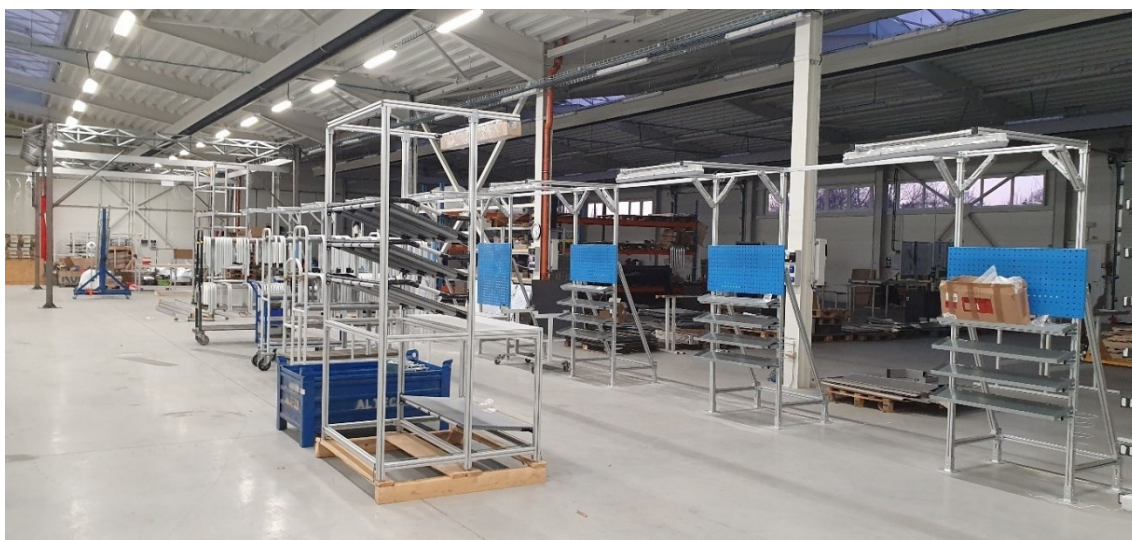
Obr. 77 Příprava druhé montážní linky schodišťových plošin Zdroj: Autor
