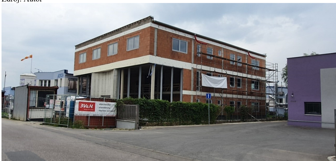
Fotografie ze dne 17.6.2020 - práce výstavby výzkumného a vývojového centra společnosti Altech Zdroj: Autor
