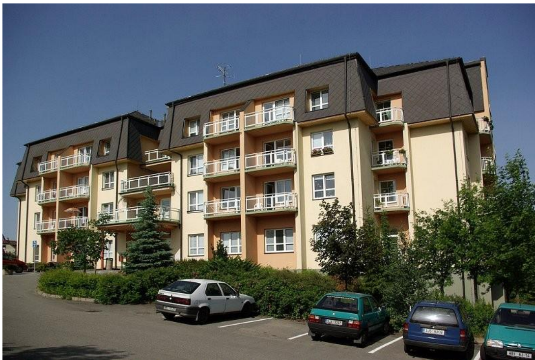
Obr. 3: Domov pro seniory ve Světlé nad Sázavou ( www.scsvetla.cz )
