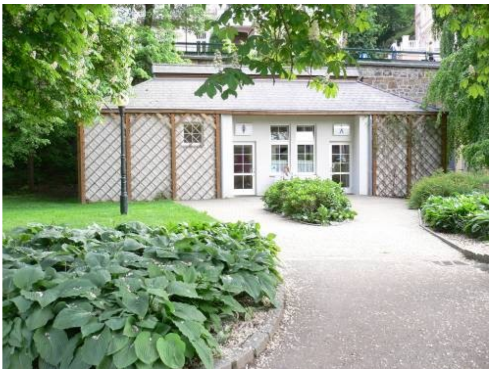
Příloha č. 6 – Budova veřejných záchodů v parku (9. 5. 2009)
