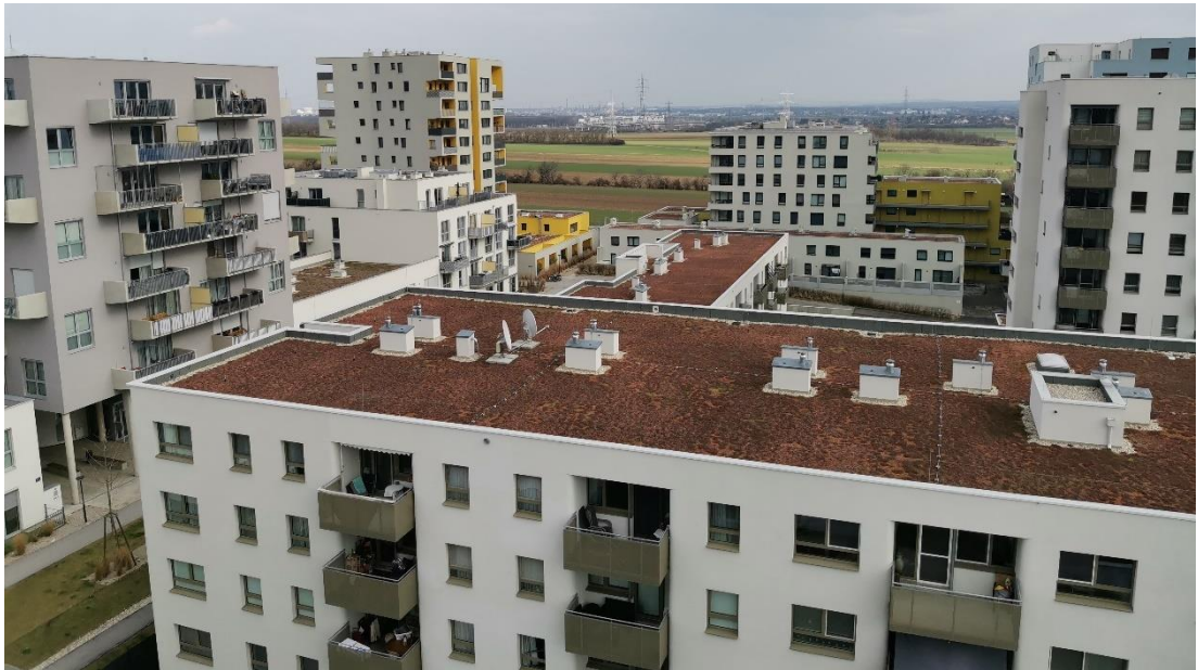
Obrázek 17: Bytový dům s extenzivní střechou v rakouské Vídni (foto autor)
