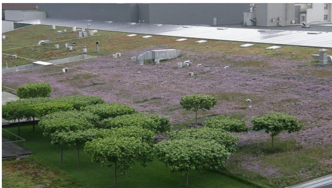
Obrázek 16: OC Nový Smíchov: celková rozloha zelené střechy činí přes 24 000 m 2 (Zahradní Architektura Kurz ©2023)
