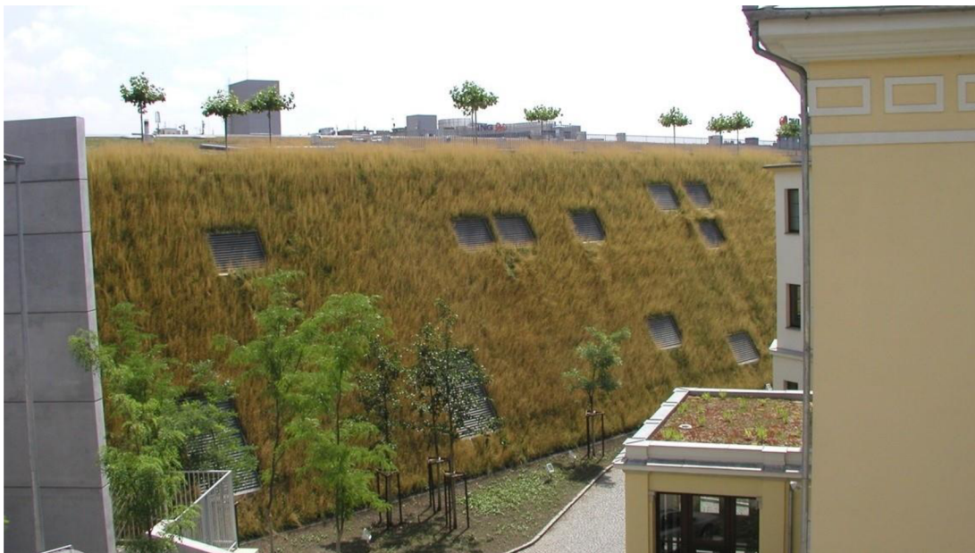
Obrázek 15: OC Nový Smíchov: světově unikátní střecha se sklonem 58° (Zahradní Architektura Kurz ©2023)
