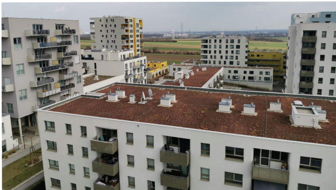
Obrázek 17: Bytový dům s extenzivní střechou v rakouské Vídni (foto autor)
