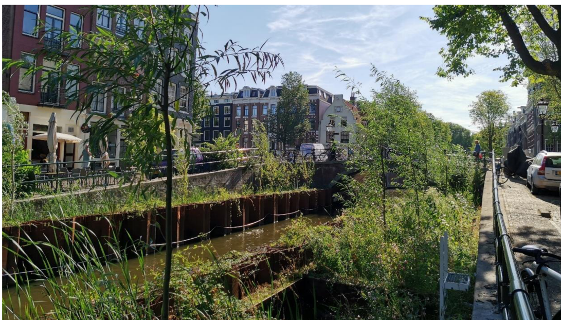
Obrázek 26: Záhony s vegetací vybudované v amsterdamských vodních kanálech (foto autor)
