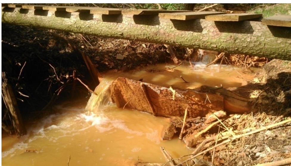
Obr. 17 Hrázka snižující rychlost proudění výsypkových vod, foto Semotam, 2014
