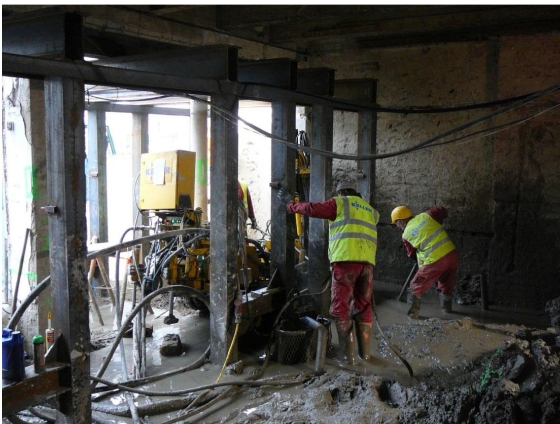
Obrázek 4-2: Provádění tryskové injektáže v domě č. 16 na Mendlově náměstí [7]
