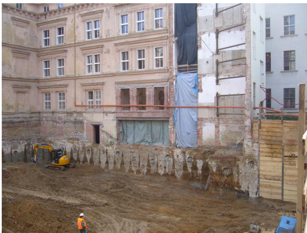
Obrázek 4-4: Objekt podchycený TI s odbouranou přesahující částí [7]
