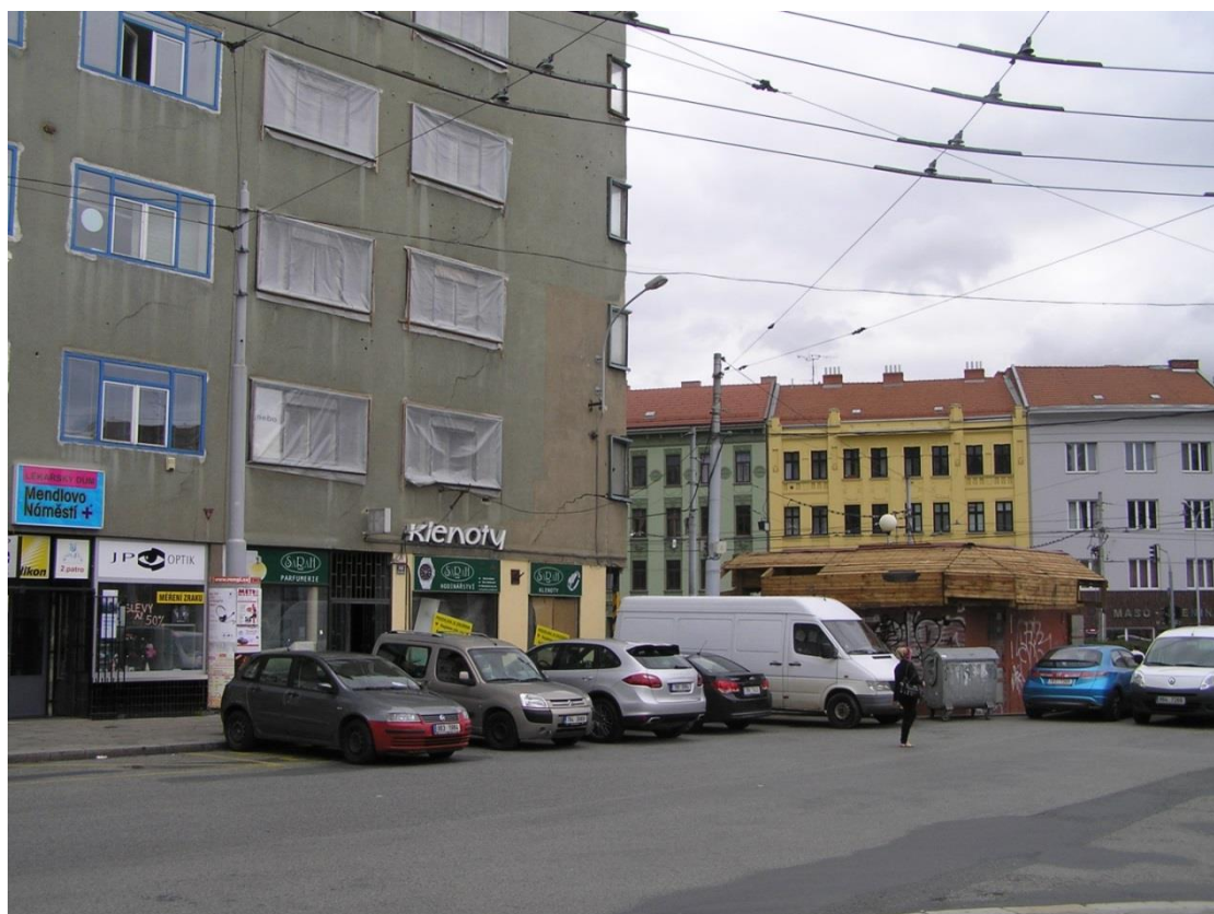
Obrázek 4-1: Trhliny v nosné zdi domu č. 16 na Mendlově náměstí [7]
