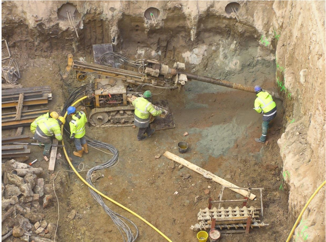
Obrázek 5-2: Vrtání horninových kotev [7]
