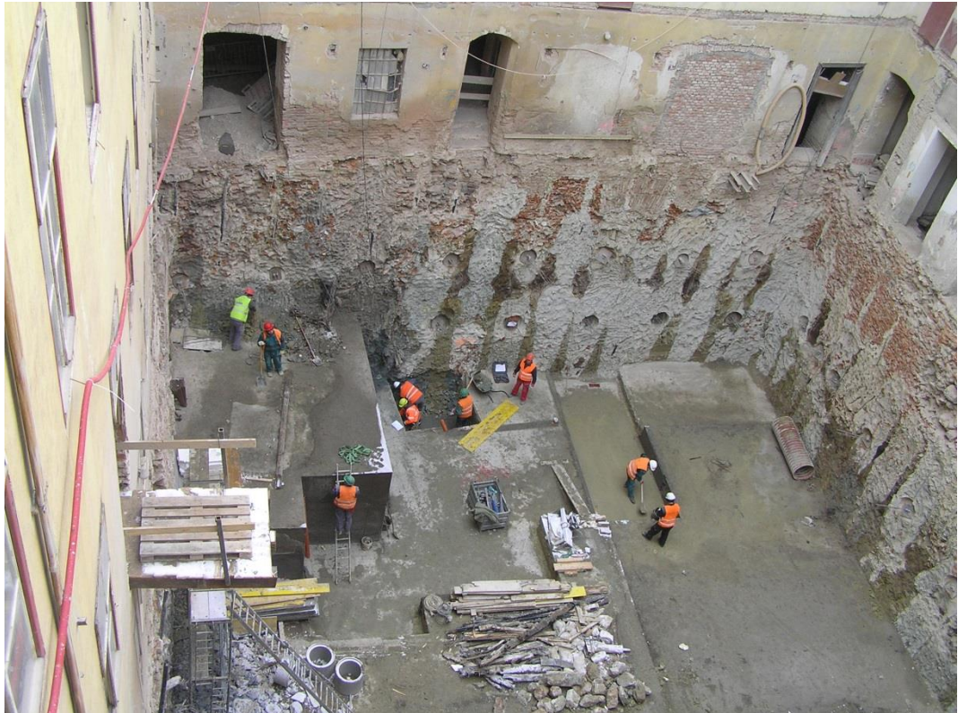
Obrázek 5-1: Stavební jáma ve vnitřním dvoře Paláce Chlumeckých [7]
