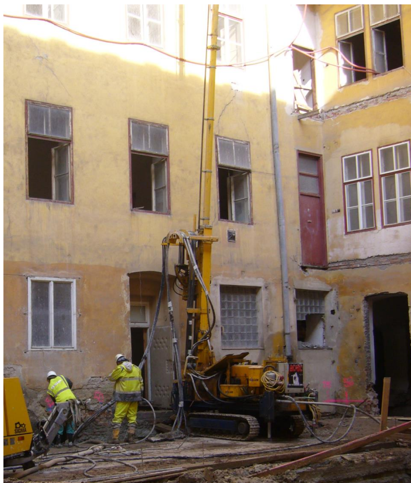
Obrázek 3-4: Maloprofilová vrtací souprava [7]
