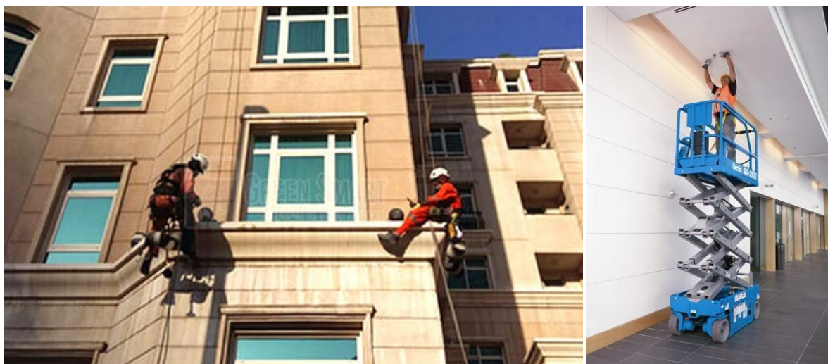
Obr. 10. Příklad montáže osvětlení na budovu
