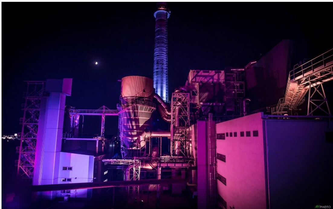
Obr. 2. Nasvícení spalovny Brno
