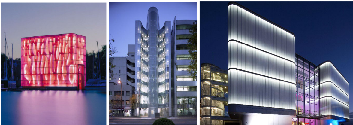
Obr. 8. Příklad osvětlení prosklených fasád budovy
