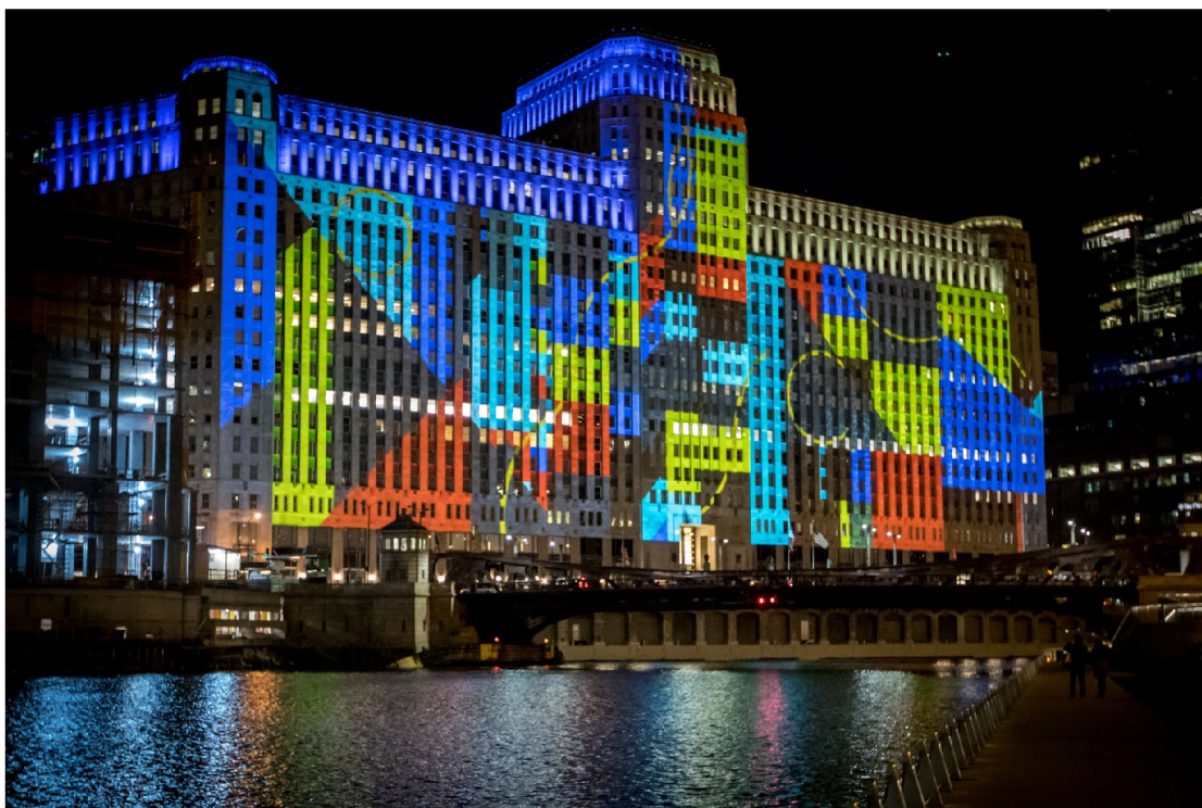
Obr. 9. Příklad osvětlení prosklených fasád budovy
