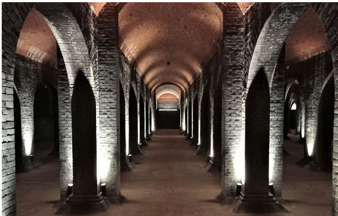
Obr. 2. Vodojem na Žlutém kopci
