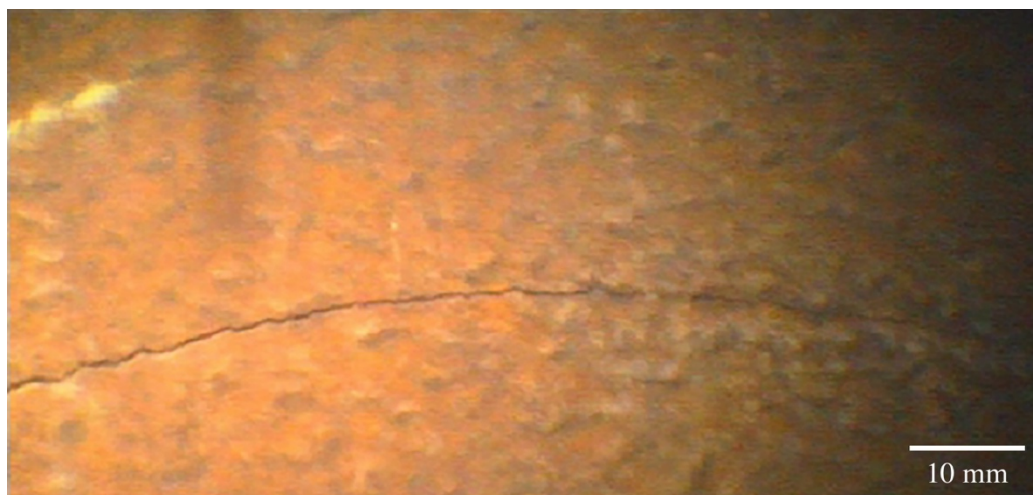
Obr. 3.2: Trhlina zjištěná pomocí videoskopu při nepřímé vizuální kontrole [7].
