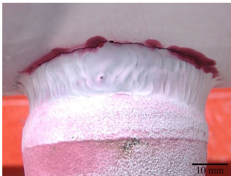
Obr. 3.5: Indikace praskliny svaru po kapilární zkoušce metodou barevné indikace [13].
