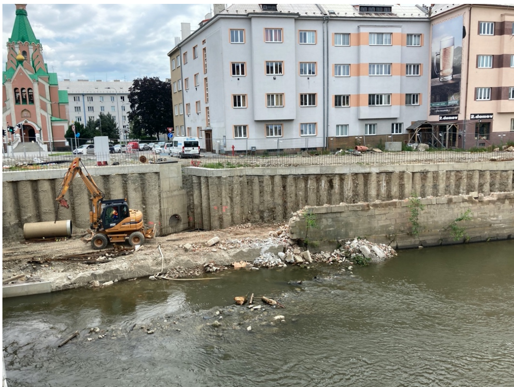
Příloha 3: Bourání nábreží při mostě Komenského, červenec 2020 (archiv autorky)
