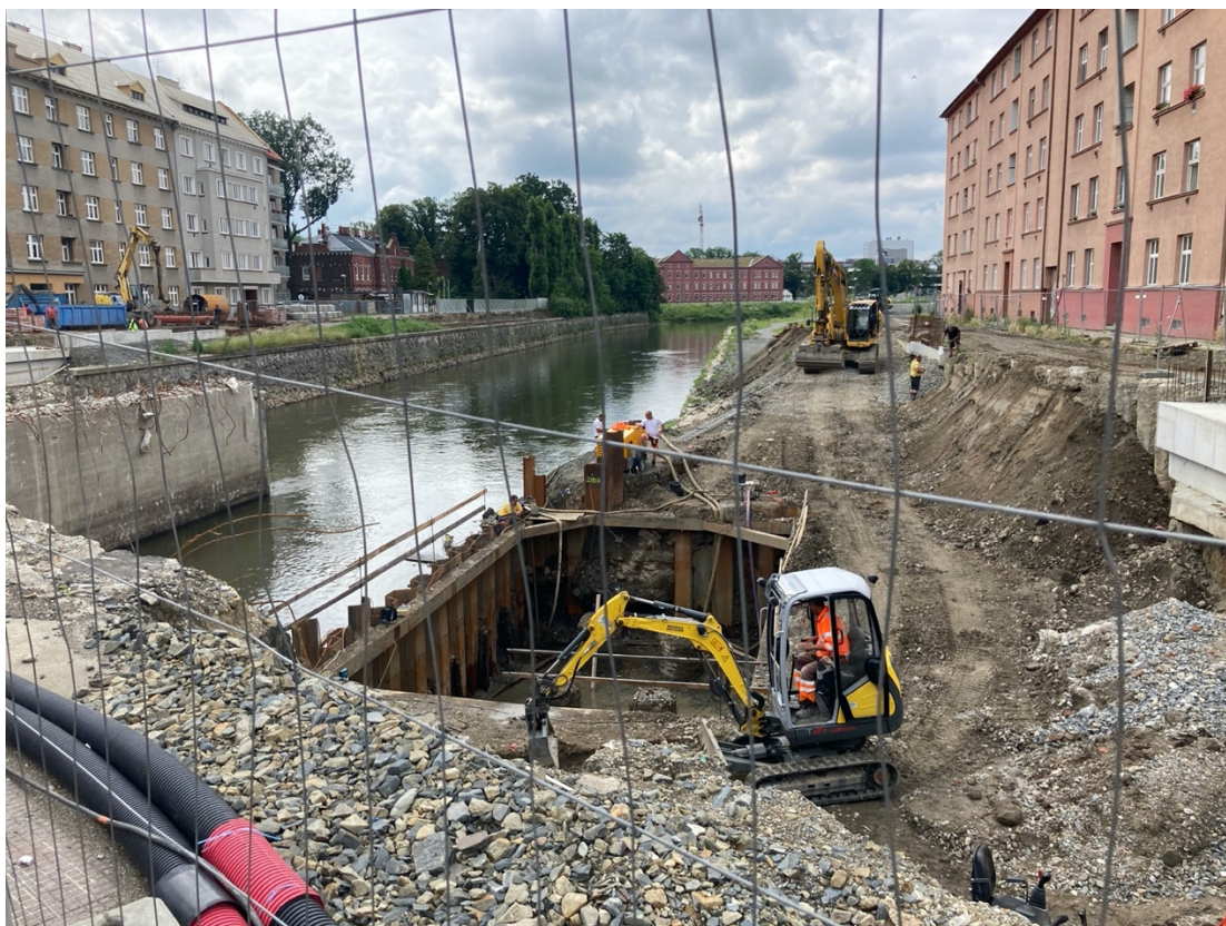
Příloha 6: Průběh stavebních úprav, červenec 2020 (archiv autorky)
