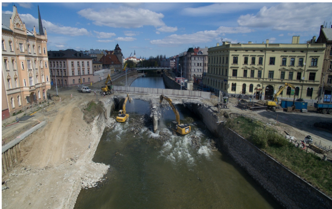
Příloha 11: Pohled z výšky na demolici mostu, duben 2020 (protipovodnovaopatreni.olomouc.eu)
