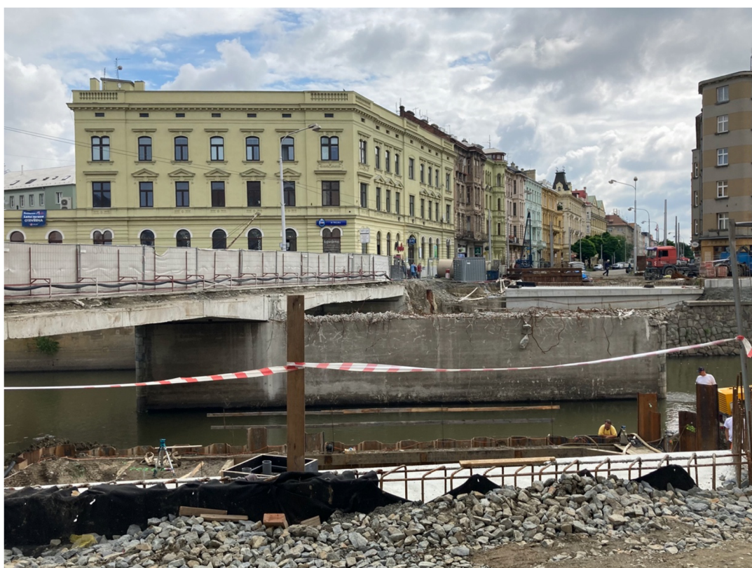
Příloha 5: Pohled na průběh bourání poloviny mostu na Masarykově třídě, červenec 2020 (archiv autorky)
