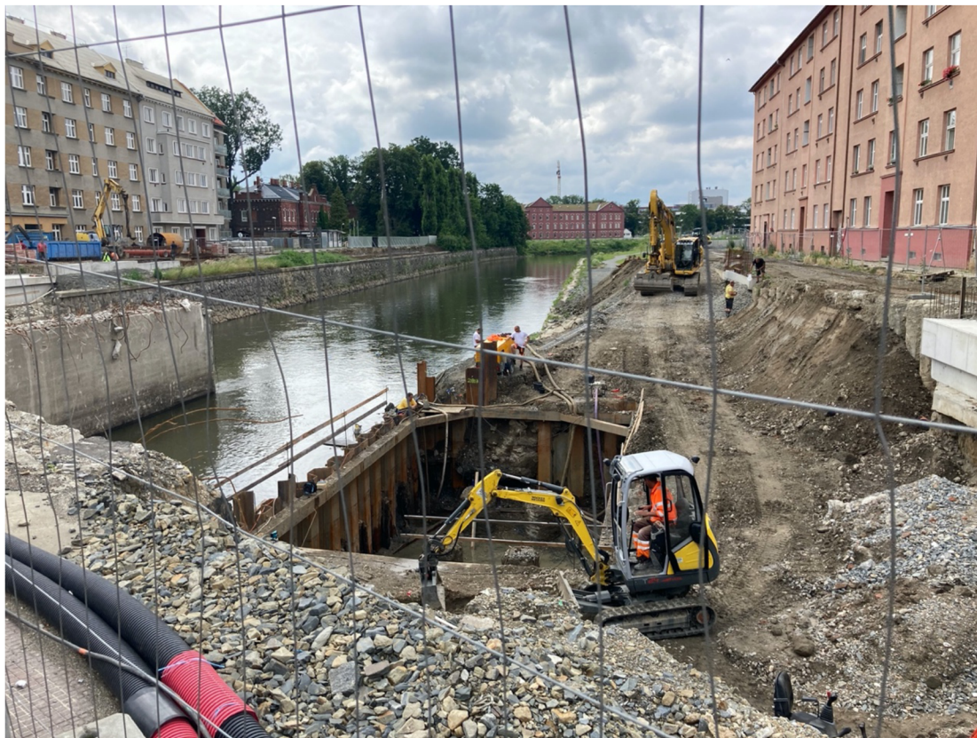
Příloha 6: Průběh stavebních úprav, červenec 2020 (archiv autorky)
