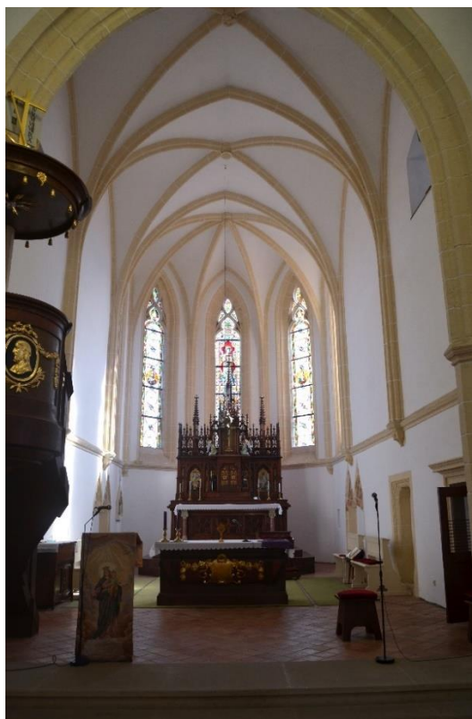
Obr. 41 – Pohled do interiéru pozdně gotického presbytáře kostela sv. Markéty v Loděnicích u Moravského Krumlova s křížovou žebrovou klenbou a lomenými okny v závěru.
