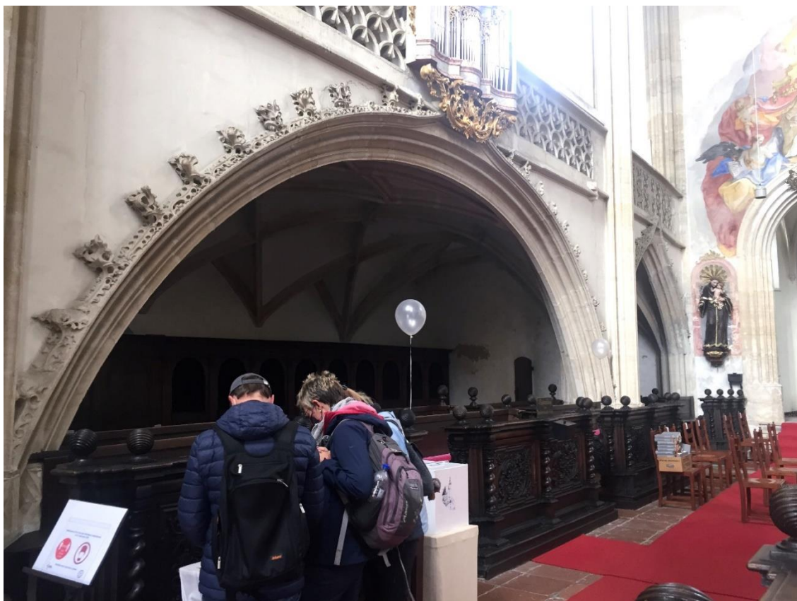
Obr. 48 – Arkádové oblouky hudební kruchty v západní části, rozkládající se přes celou šířku trojlodí v interiéru piaristického kostela Panny Marie v Kremžiči.
