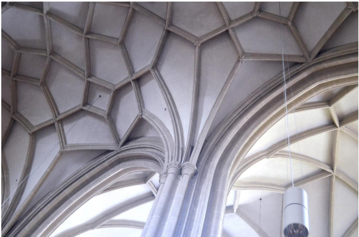
Obr. 25 – Detail hlavní klenby s hluboce profilovanými lomenými oblouky a svazkovým pilířem snášející váhu kleneb v kostele sv. Štěpána v Eggenburgu.
