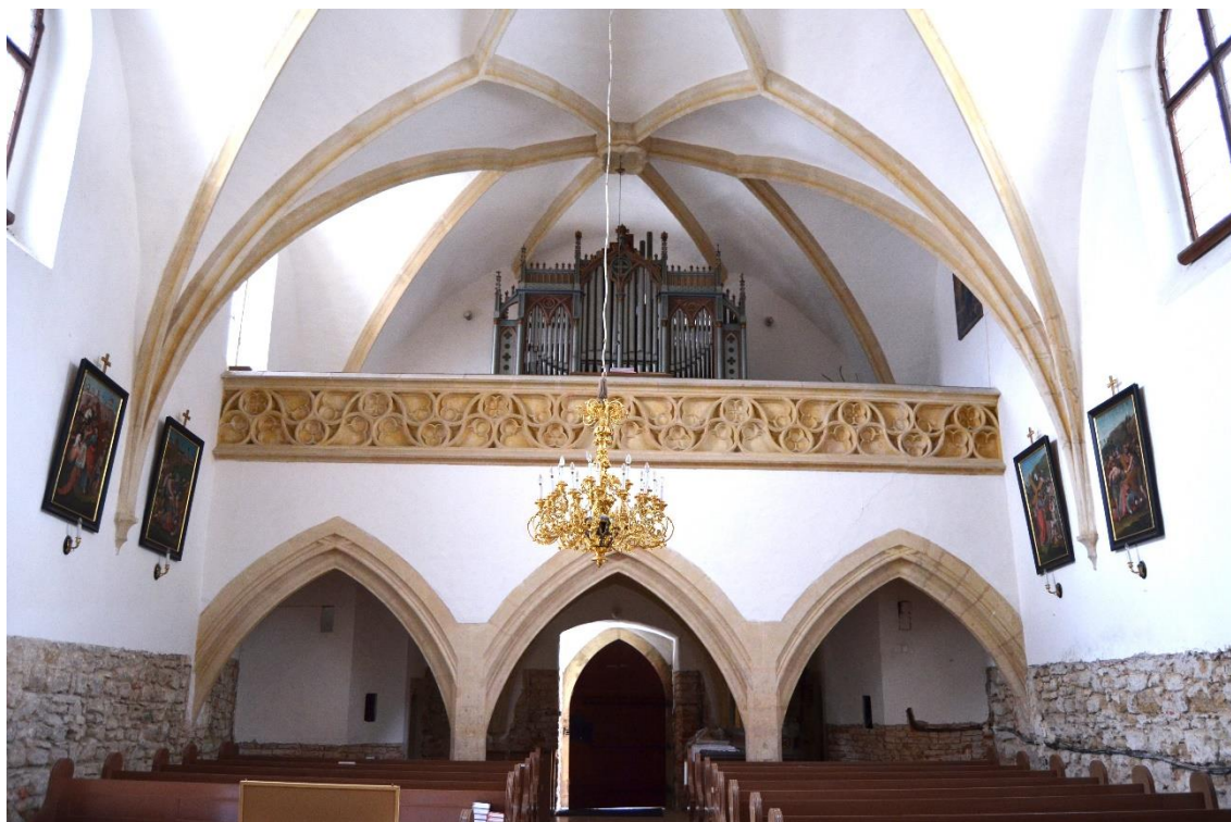
Obr. 20 – Interiér lodi kostela sv. Jana Křtitele v Kurdějově. Pohled na hudební kruchtu v západní části lodi se třemi arkádovými oblouky lomeného tvaru.
