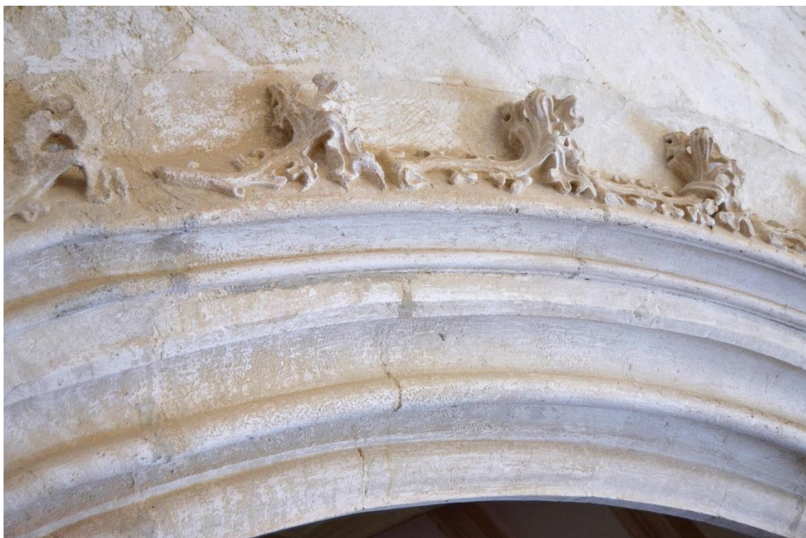
Obr. 8 – Detail kamenické výzdoby pomocí kamenných krabů a profilace arkádových oblouků v interiéru trojlodí kostela sv. Wolfganga v Hnanicích u Znojma.
