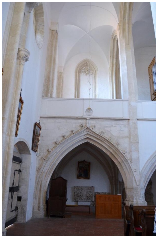
Obr. 7 – Lomený oblouk hnanické kruchty navazující na jednu z vedlejších lodí kostela sv. Wolfganga. Patrné chybějící zakončení křížové kytky, které bylo součástí původního kamenného parapetu.
