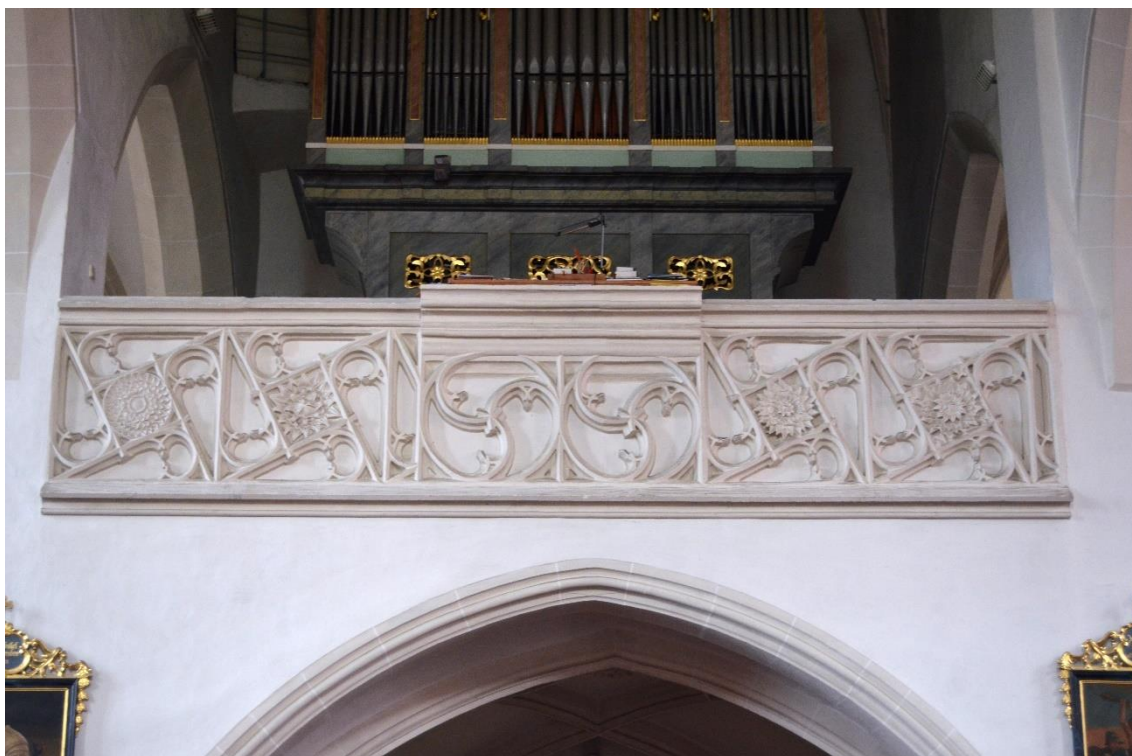
Obr. 57 – Střední část kamenného parapetu hudební kruchty s motivem slepé kružby v kostele Navštívení Panny Marie v Maria Laach am Jauerling.
