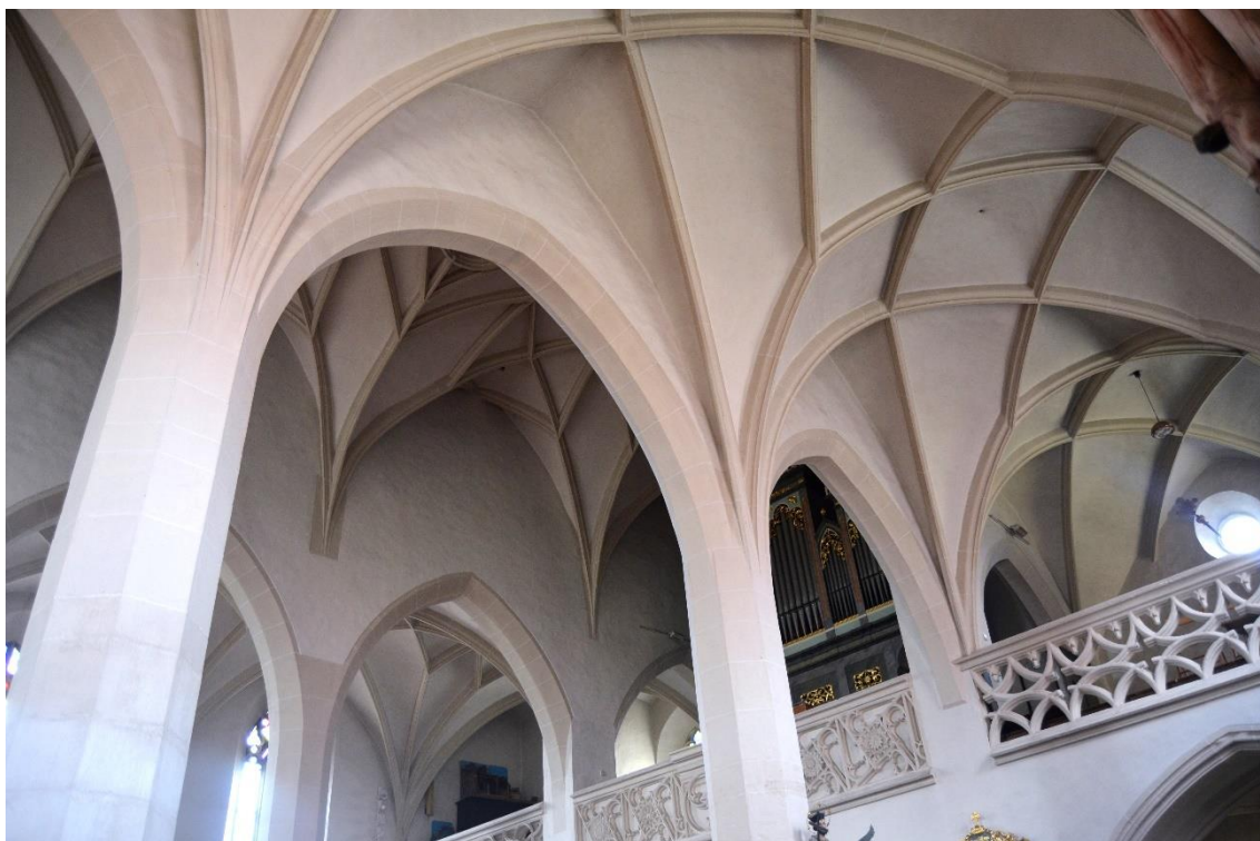
Obr. 55 – Pohled na lomené oblouky a pilíře snášející váhu kleneb v trojlodí kostela Navštívení Panny Marie v Maria Laach am Jauerling.
