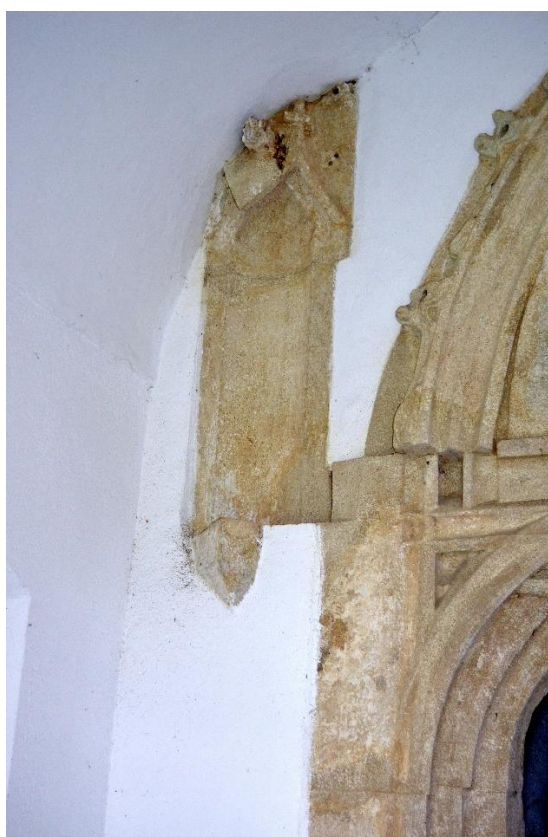
Obr. 34 – Detail kamenické výzdoby jižního portálu kostela sv. Markéty ve Chvalovicích u Znojma – jeden z postranních baldachýnků, jehož završení ustoupilo výstavbě předsíně.
