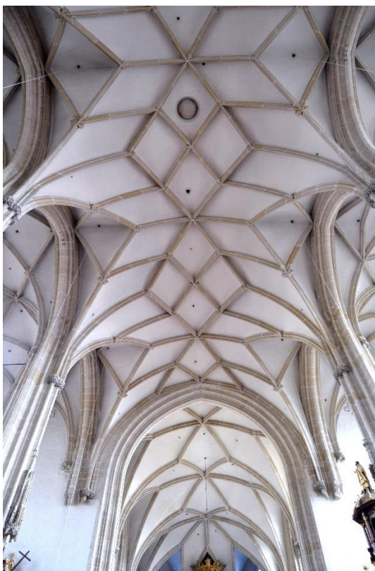
Obr. 45 – Pohled na hvězdicovou žebrovou klenbu hlavní loďe piaristického kostela Panny Marie v Kremži s lomenými oblouky a svazkovými pilíři.
