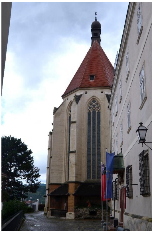
Obr. 43 – Pohled na východní polygonální záměr piaristického kostela Panny Marie v Kremžiči s vysokými lomenými okny s kamennými kružbami ve vrcholu.
