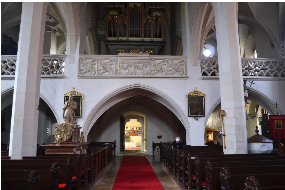
Obr. 56 – Západní hudební kruchta nesena třemi arkádovými oblouky zasazena do interiéru trojlodí kostela Navštívení Panny Marie v Maria Laach am Jauerling.
