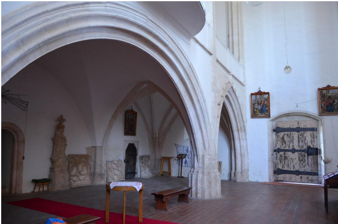
Obr. 6 – Interiér kostela sv. Wolfganga v Hnanicích u Znojma. Pohled na arkády nesoucí hudební kruchtu.
