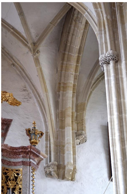
Obr. 46 – Kamenný lomený oblouk a svazkové přípory v interiéru trojlodí piaristického kostela Panny Marie v Kremži snášející tíhu kleneb.
