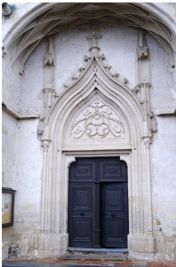
Obr. 50 – Hlavní portál kostela Panny Marie v Kremžič na jižním průčelí s výrazně profilovaným kamenným ostěním, chráněn mělkou předsíní.
