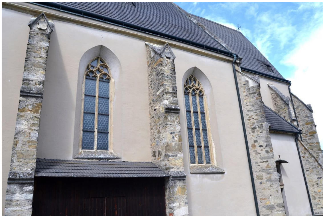
Obr. 60 – Pohled na exteriér jižního průčelí kostela Navštívení Panny Marie v Maria Laach am Jauerling s kamennými opěrnými pilíři a vysokými lomenými okny s rozlišnými motivy kružeb ve vrcholech.
