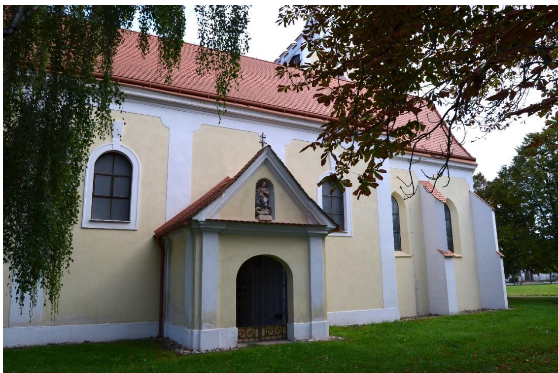
Obr. 30 – Jižní průčelí kostela sv. Markéty ve Chvalovicích u Znojma s nověji přistavěnou barokní předsíní.
