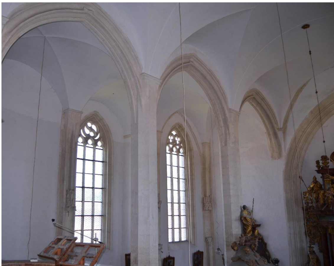
Obr. 10 – Pohled do interiéru trojlodí kostela sv. Wolfganga v Hnanicích u Znojma. Středové pilíře a kamenné lomené oblouky snášející váhu klenby.
