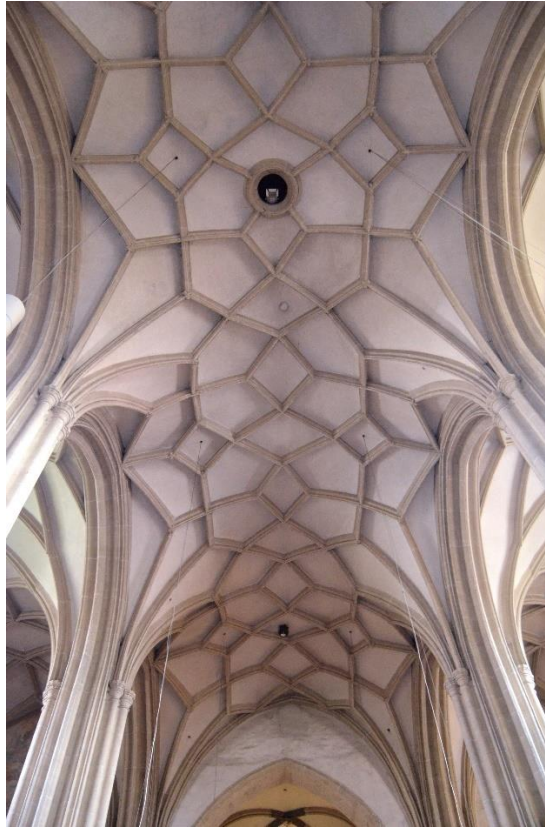
Obr. 24 – Pohled na síťovou žebrovou klenbu hlavní lodi kostela sv. Štěpána v Eggenburgu.
