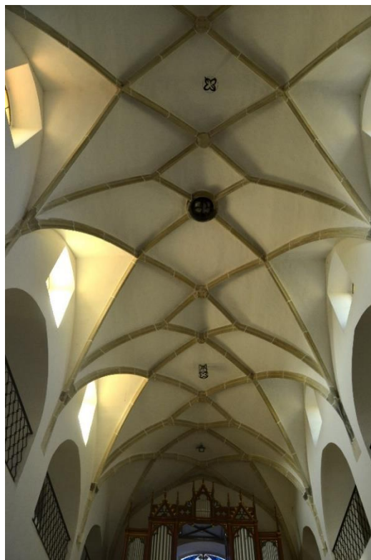
Obr. 42 – Zaklenutí hlavní lodi kostela sv. Markéty v Loděnicích u Moravského Krumlova žebrovou hvězdicovou klenbou.
