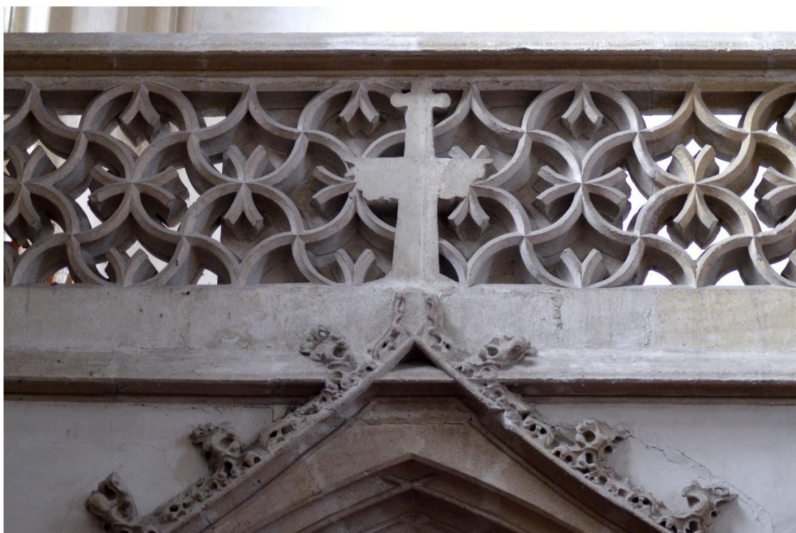
Obr. 49 – Pohled na část kamenné kružby parapetu kruchty s detailem vrcholu lomeného arkádového oblouku jedné z vedlejších lodí piaristického kostela Panny Marie v Kremžiči. Znatelný negativní otisk původní vrcholící křížové kytky.
