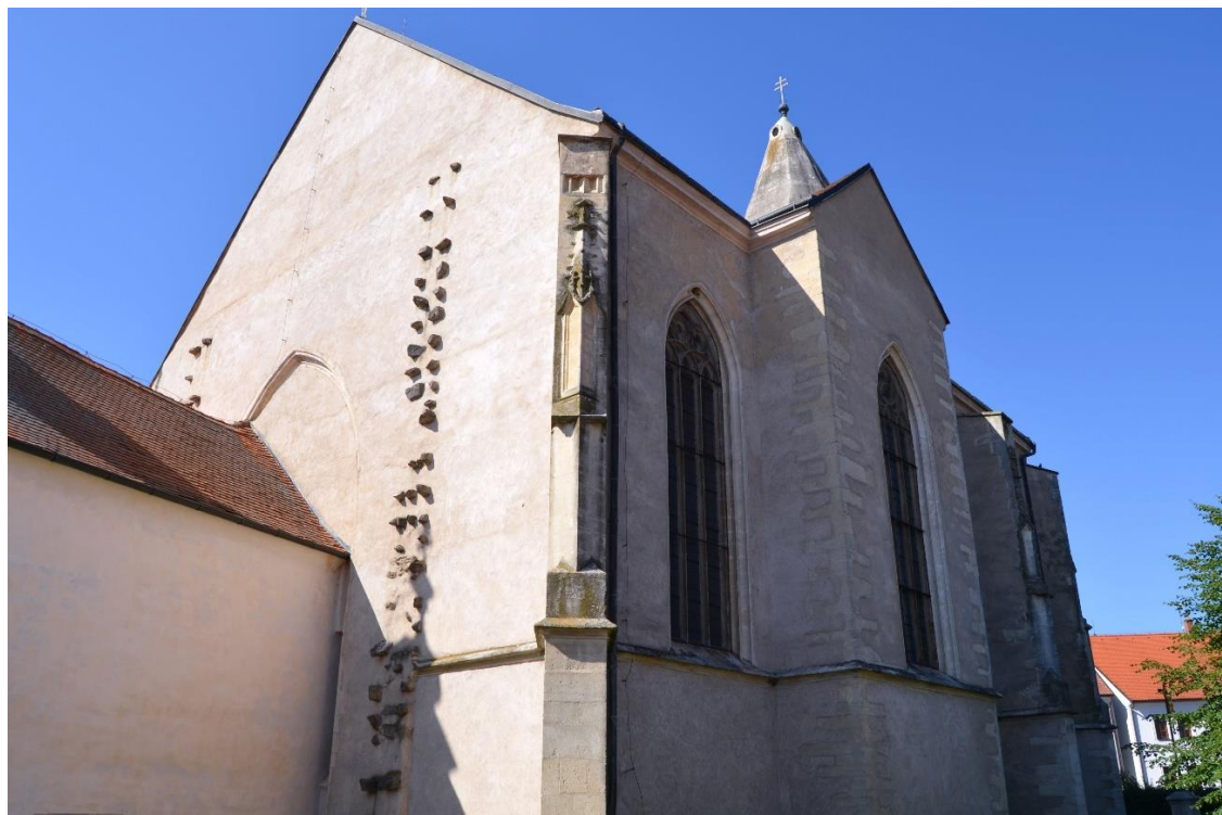
Obr. 2 – Pohled na východní štít trojlodí kostela sv. Wolfganga v Hnanicích u Znojma s vystupujícími kameny na chystaný presbytář.
