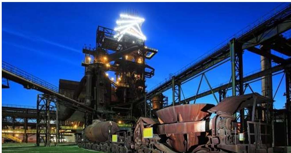
Obrázek 5: Bolt Tower v areálu Dolních Vítkovic
