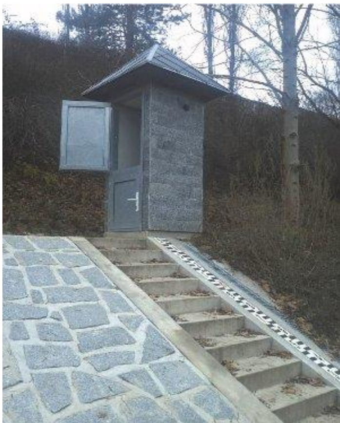
Obrázek 2 Ukázka vodoměrné stanice (CHMÚ, 2021).
