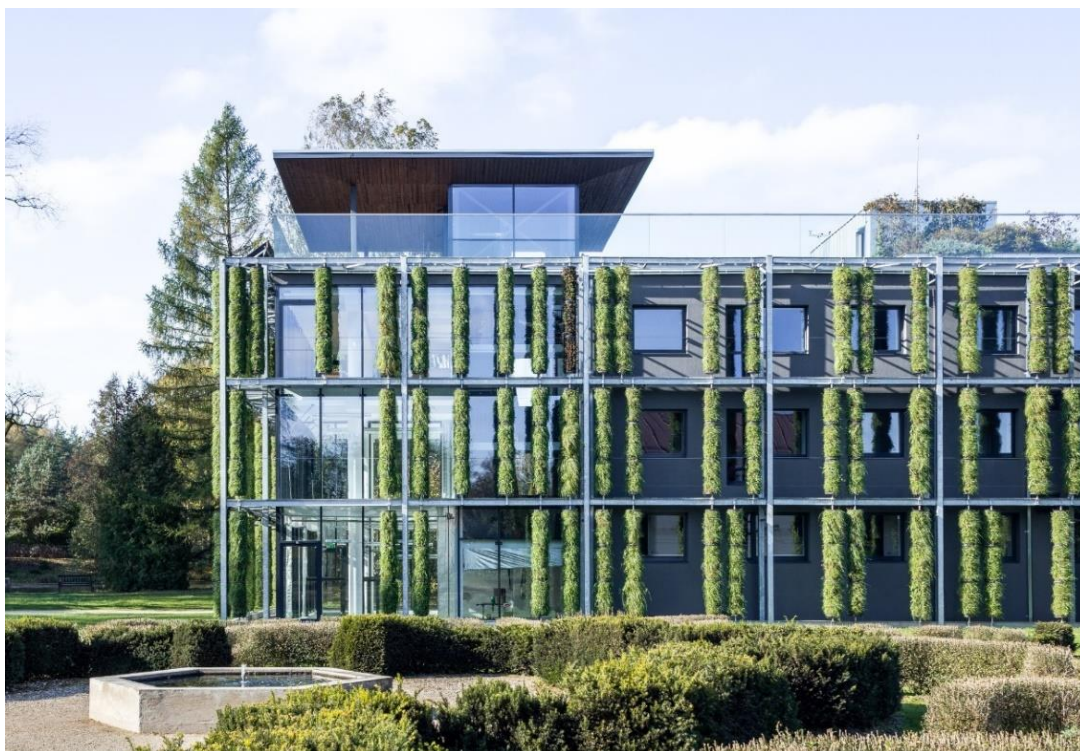
Obrázek 1: Předsazená zelená fasáda. Zahradní laboratoř botanické zahrady Univerzity Vilnius, Litva, foto: Norbert Tukaj 2017
