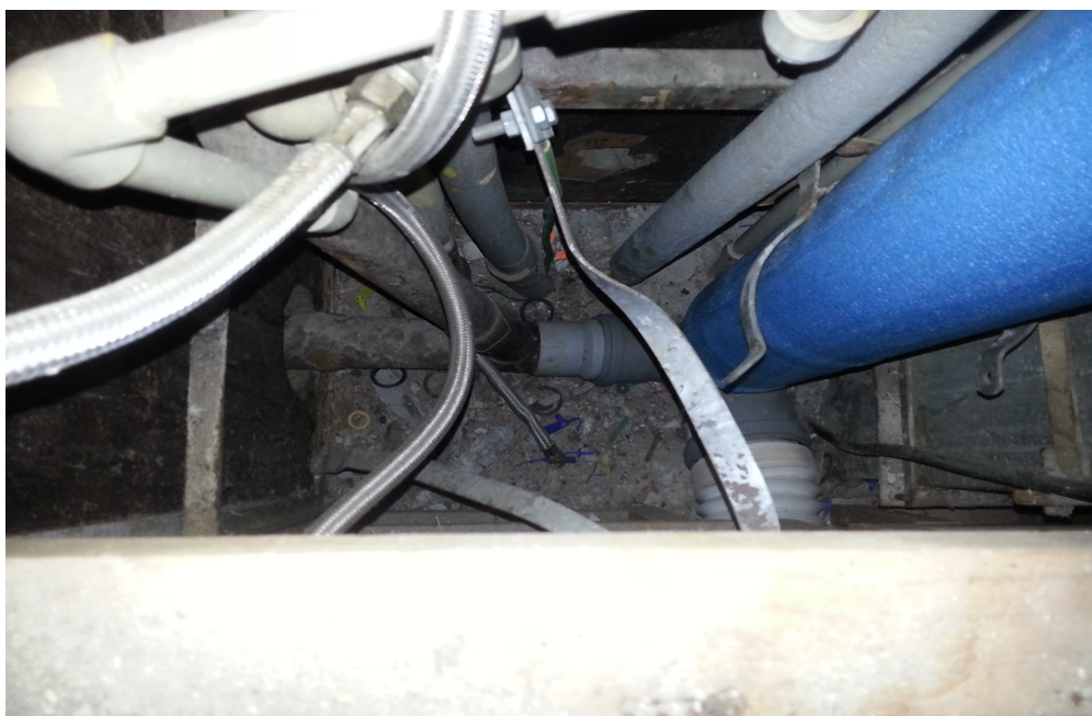
Obr.č.3 Foto stávajících rozvodů v bytovém jádru
