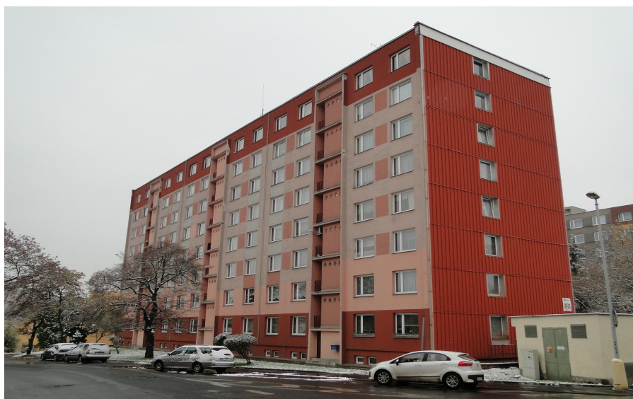
Obr.č.6 objekt T06 B ve kterém bylo prováděno měření a podklady k výpočtům
