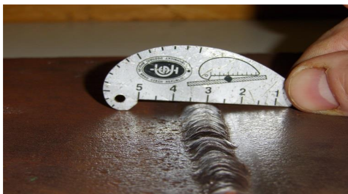
Fotografie č. 13 – Měření převýšení svaru na tupu
