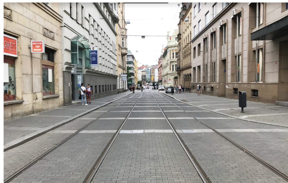
Ulice Rašínova - Původní stav
