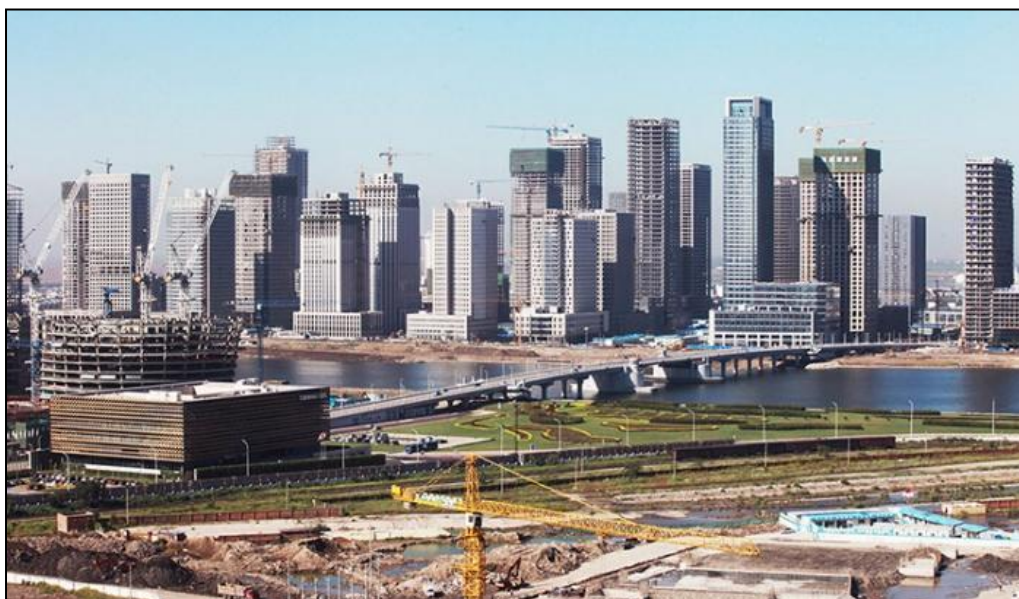
Obrázek č. 2 – Pohled na rozestavěnou verzi čínského Manhattanu
