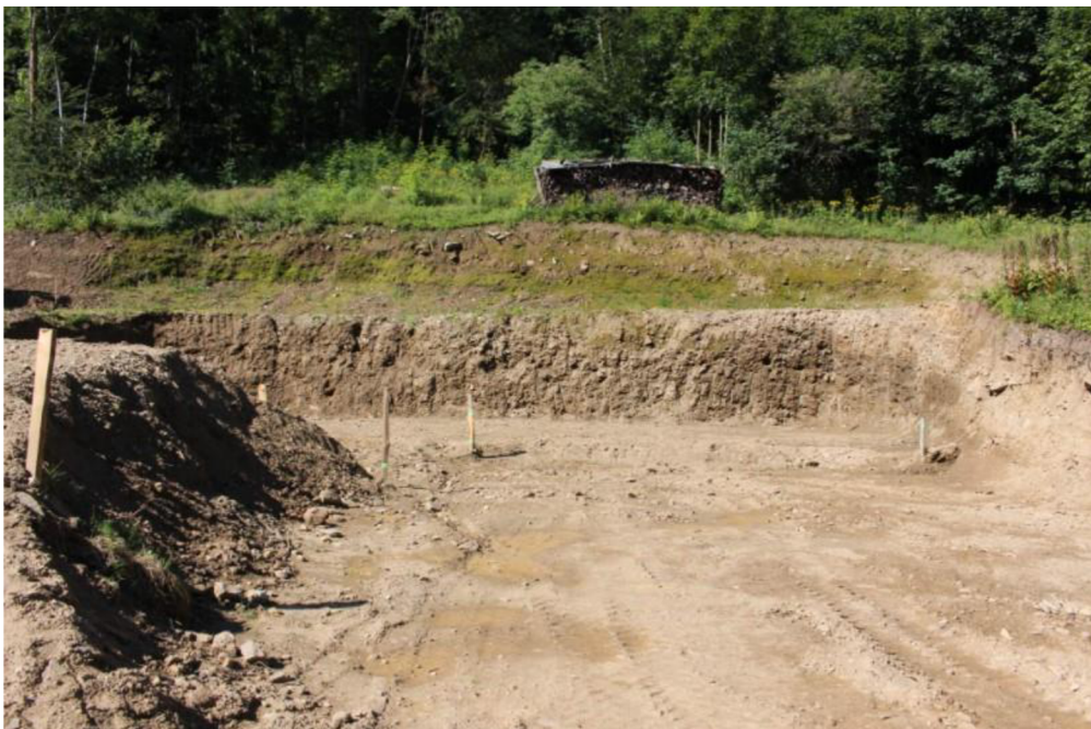
Obr. 3 Zabudování stavby do svahu [4]
