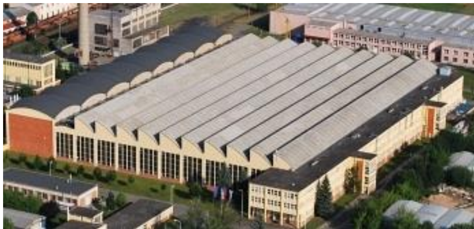
Obrázek 15: Budova firmy TOSHULIN, a.s., Hulín 13
