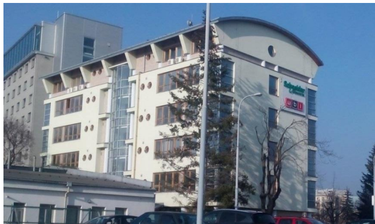
Obrázek 11: Střecha se štítem ve tvaru kruhové výseče 9
