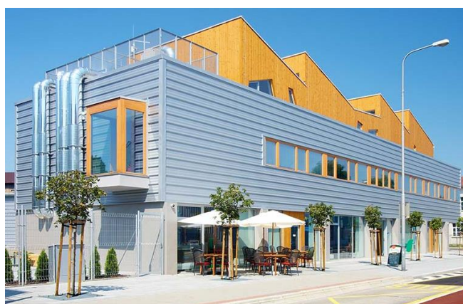
Obrázek 69: Střecha pilová na polyfunkčním domě v Ostravě - Vítkovicích
