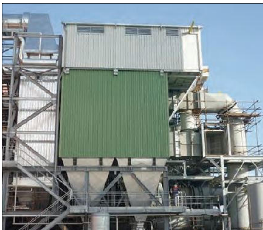
Obr. č. 3.18: Tkaninový filtr pro čištění spalin, zdroj: [2]
