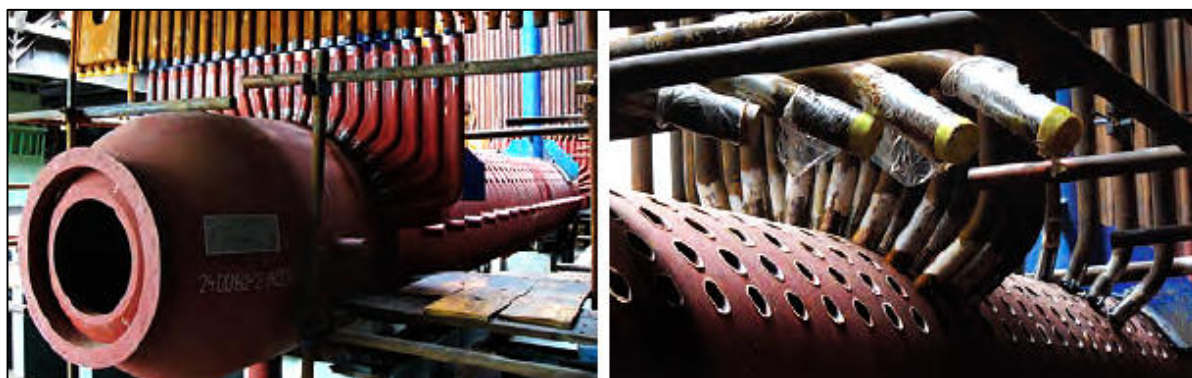
Obr. č. 3.7: Montáž kotlového svazku a spodní bubeny, zpracováno dle: [2]
