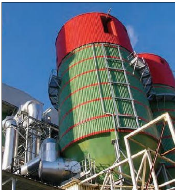
Obr. č. 3.16: Absorbér pro čištění spalin, zdroj: [2]
