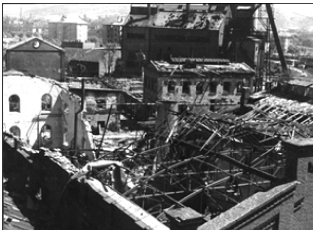
Obr. č. 2.2: Vybombardování spalovny v 2. světové válce, zdroj: [14]
