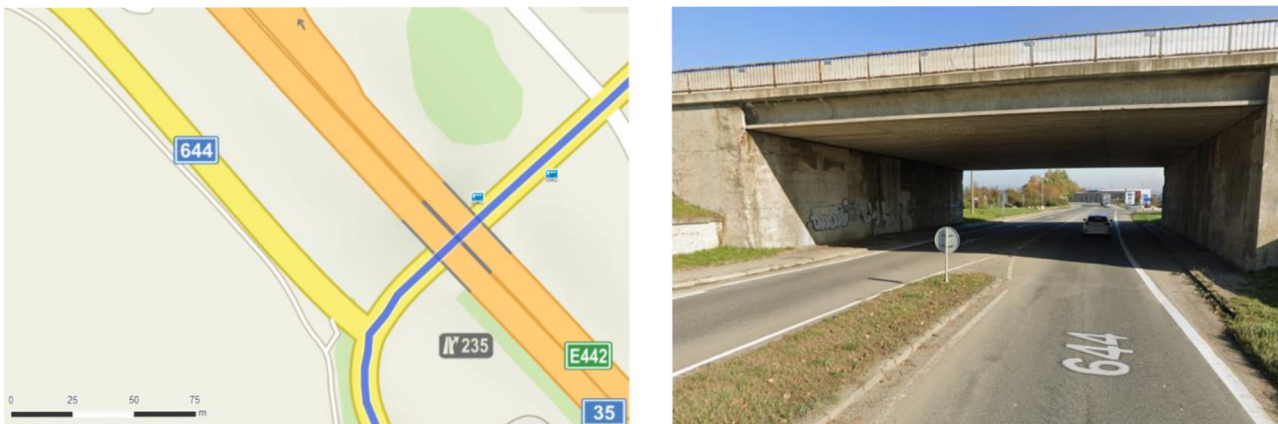
Obrázek 11 – Podjezd pod mostem [1][2]
