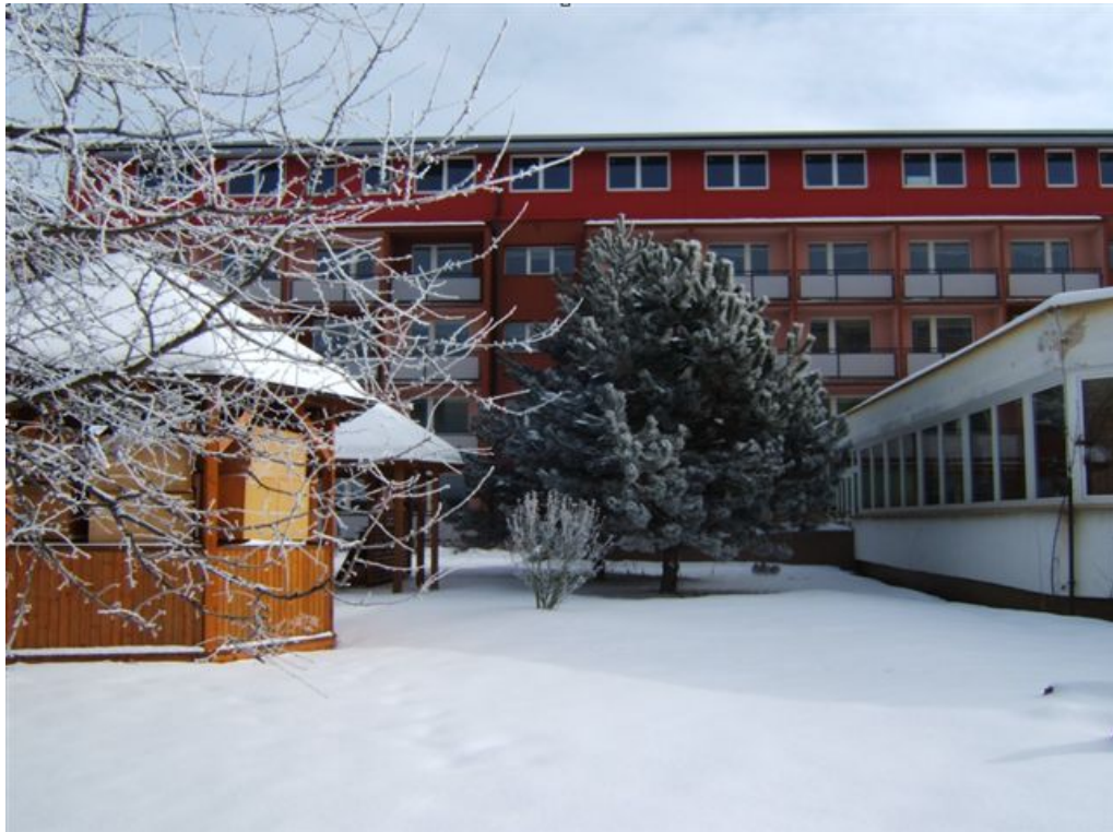
9 Rekonstrukce Domova pro seniory v Uherském Hradišti – přístavba
