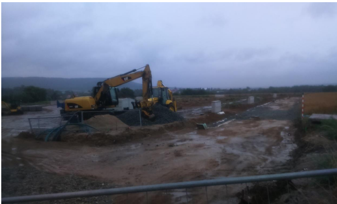
Před výstavbou komunikace (realizovány veškeré IS, sdružené pilíře).
