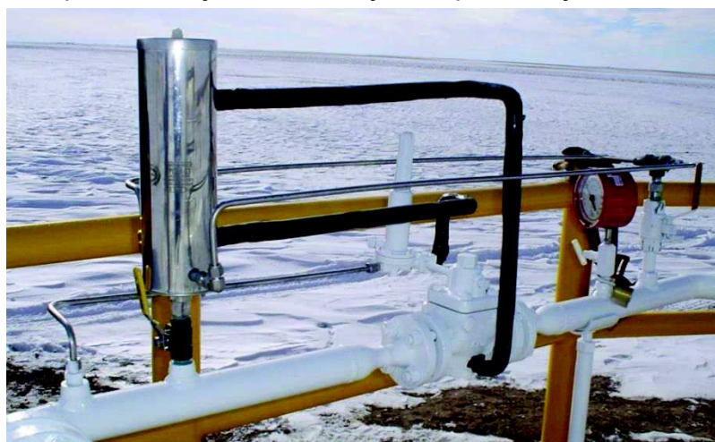
Obrázek 8: Regulační ventil s vírovým ohřivačem [16]
