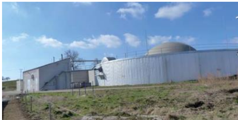
Obrázek 7: Bioplynová stanice Červené Janovice (Procházka & Svobodová 2017)
