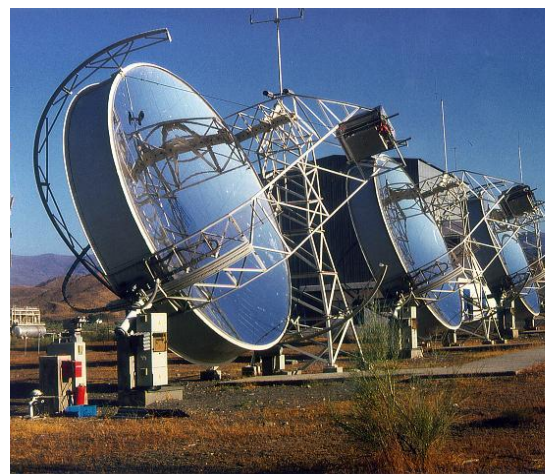
Obrázok 7. Diskový zberač (9kW) umiestnený v Almería, Španielsko [4]
