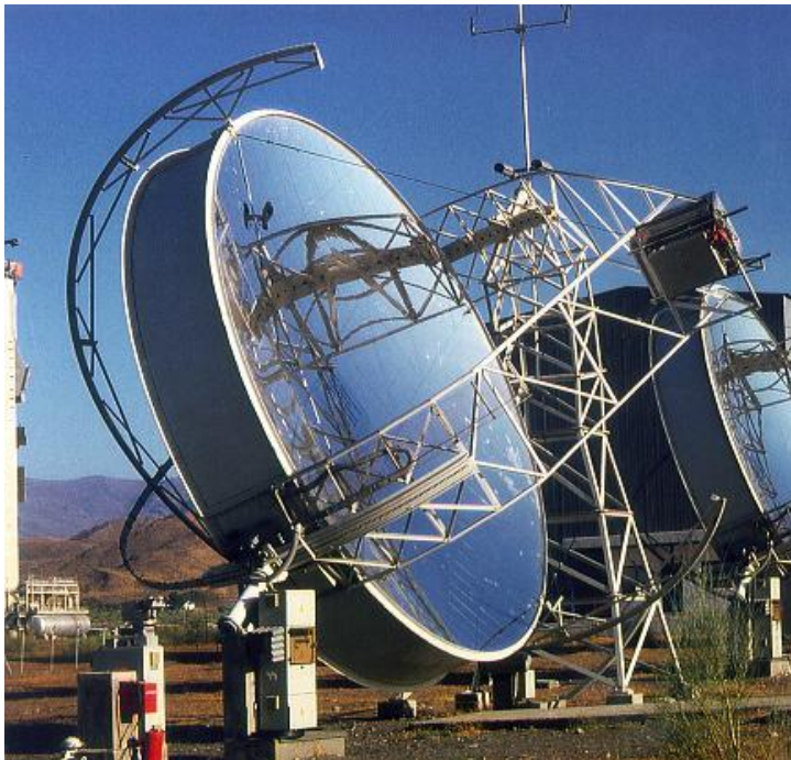
Obrázok 24. Prevedenie polárneho sledovacieho systému v praxi [4]
