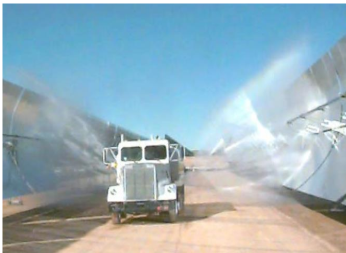
Obrázok 42. Čistenie zrkadiel tlakovou vodou [18]
