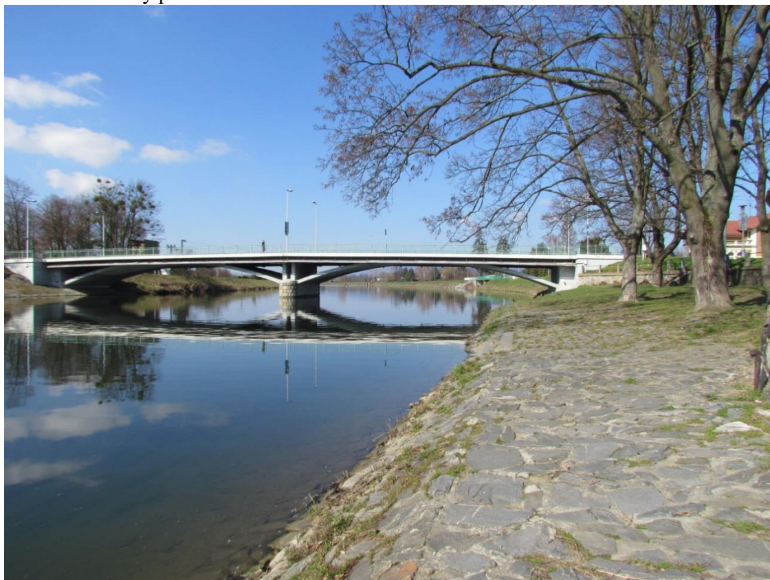
Obrázek 45 Most v Hranicích na Moravě Zdroj: vlastní foto
