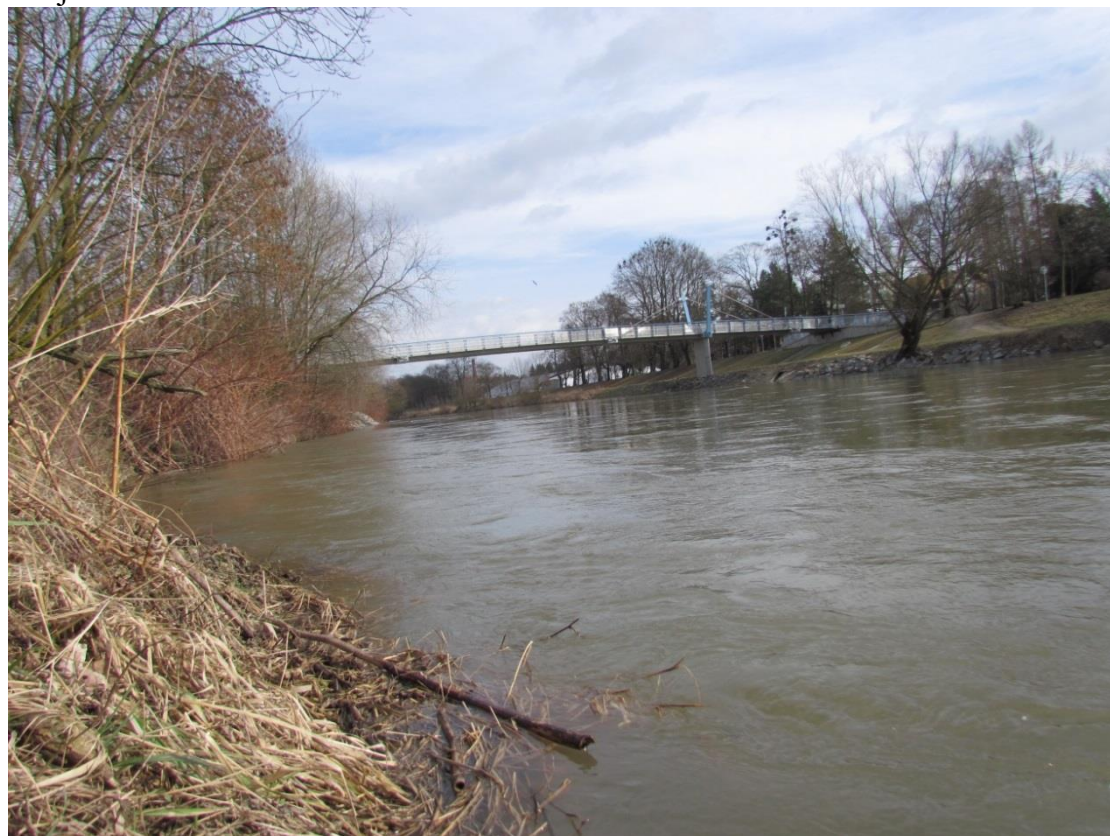
Obrázek 46 Lávka u Tenisu v Přerově Zdroj: vlastní foto
