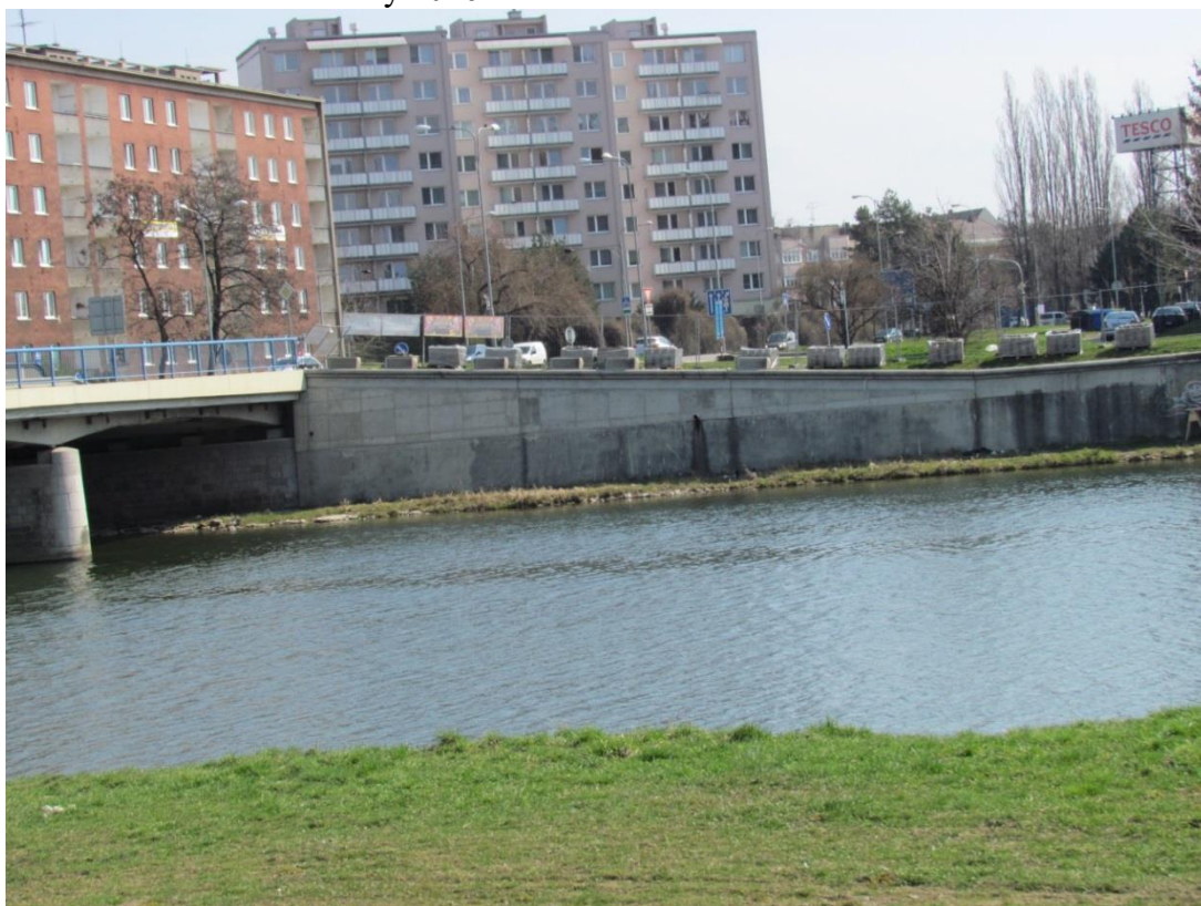
Obrázek 25 Nábřeží PFB, rekonstrukce protipovodňové zídky 2016 Zdroj: vlastní foto
