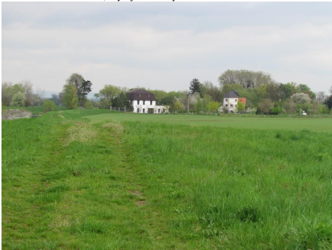
Obrázek 31 Protipovodňová hráz v Troubkách 2016
