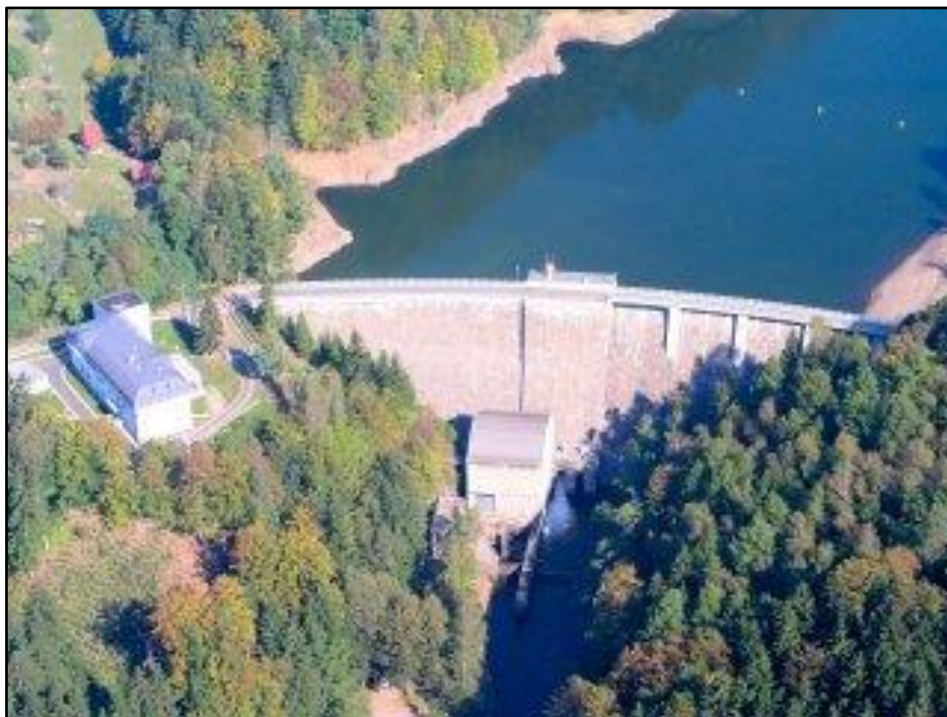
Obr. 2: Hráz vodní elektrárny Pastviny (Dofelder, 2019)
