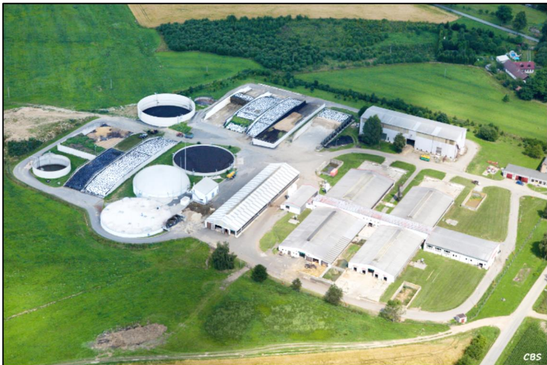
Obr. 16: Bioplynová stanice (Rozvodi, 2018)
