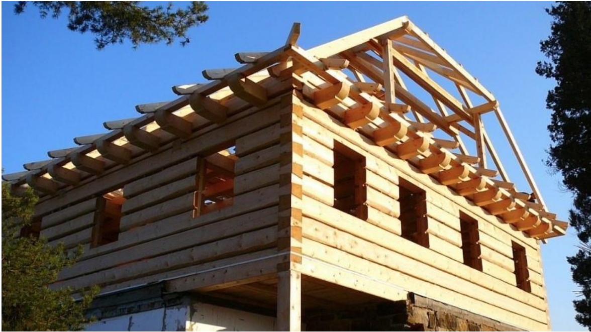
Obrázek 15. Roubená stavba. Zdroj: Sruby Bernart, s.r.o., 2013
