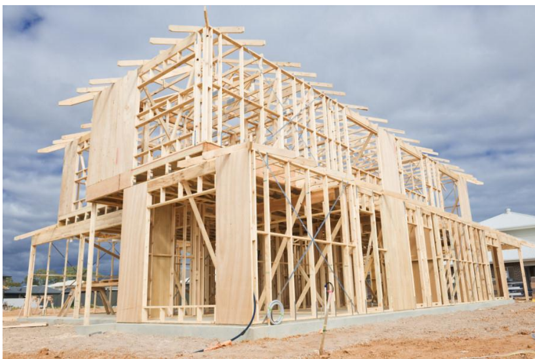
Obrázek 11. Dřevostavba z lehkého skeletu. Zdroj: Lev, 2019
