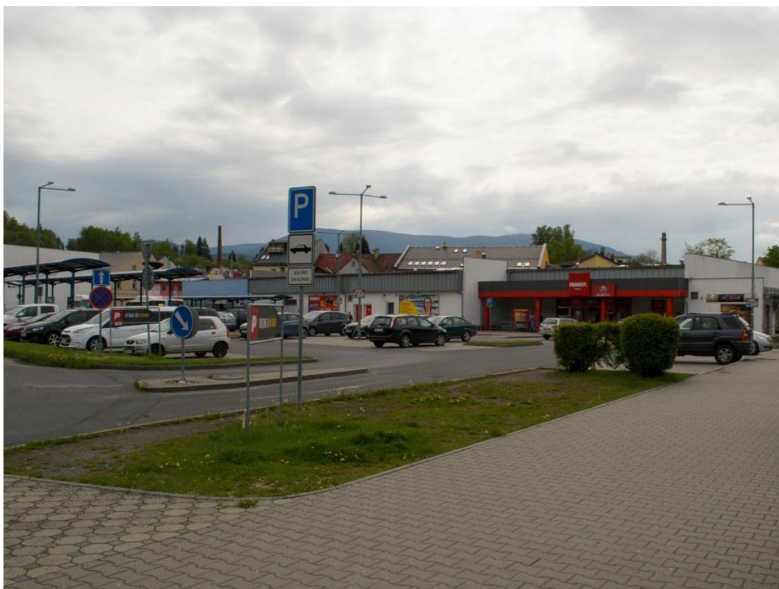
Obr. 8: Zmiňovaná oblast autobusového nádraží, zdroj: autor
