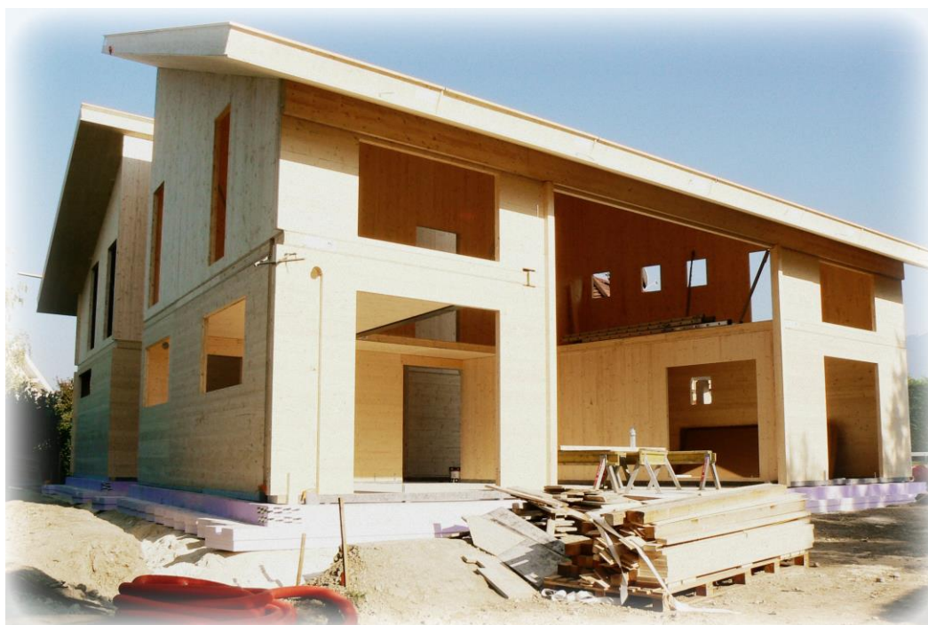
Obr.19: Stavba z masivního lepeného dřeva NOVATOP [ http://www.novatop-system.cz ]
