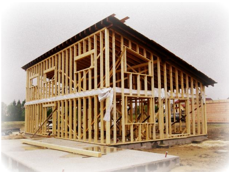
Obr.7: Konstrukce Akastav s I stojnou [woodsystem]
