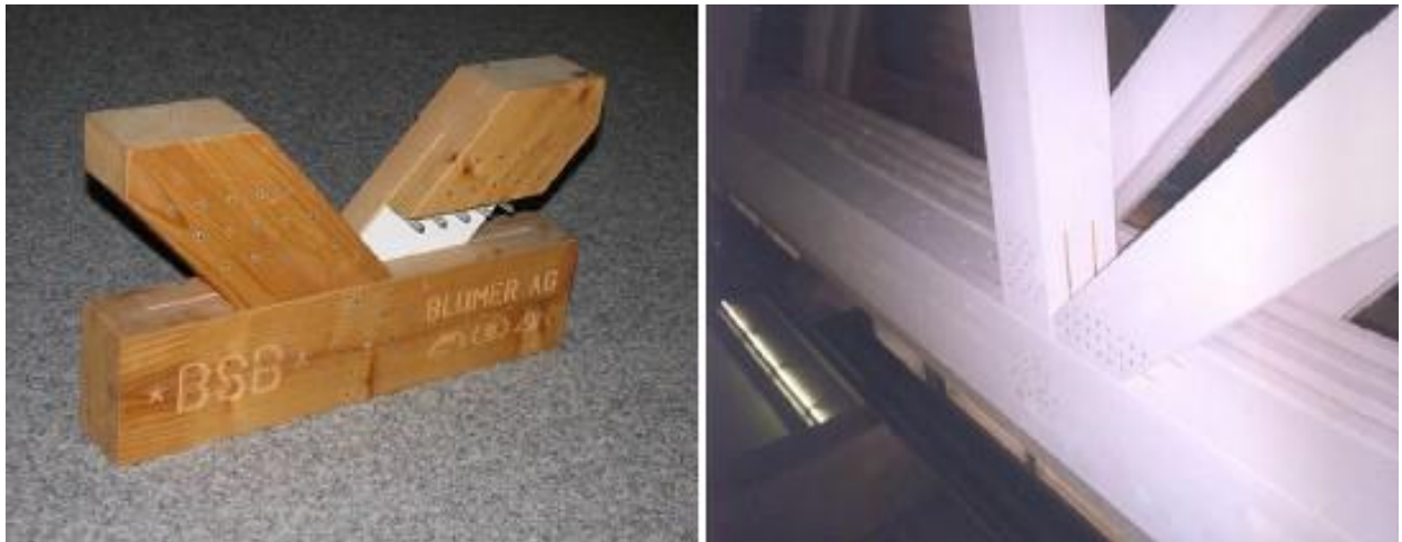
Obrázek 20 Příhradový vazník s ocelovými kolíky
