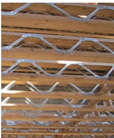
Obrázek 21 Vyobrazení jednotlivých vazníků s kovovými prvky
