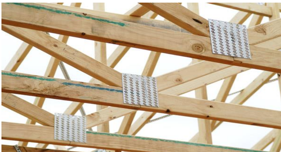
Obrázek 2 Zobrazení konkrétních styčnickových desek
